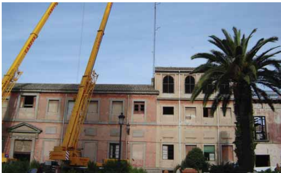
Fachada del Hospital de la Misericordia y el torreón al inicio e las obras.
