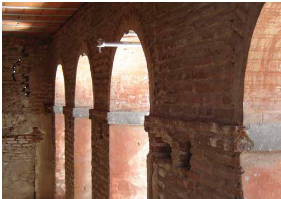
Vista del ala oeste con los arcos de la sala de exposiciones de la primera planta.
