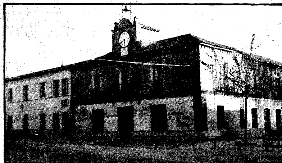
Edificio del Ayuntamiento.
