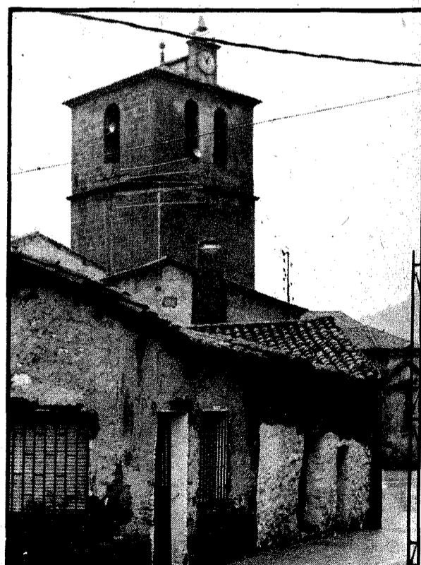
Torre de la iglesia parroquial, construída en piedra de sillería.
