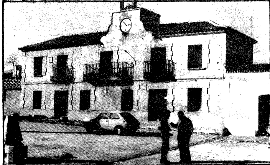
El edificio del Ayuntamiento en la Plaza principal.
