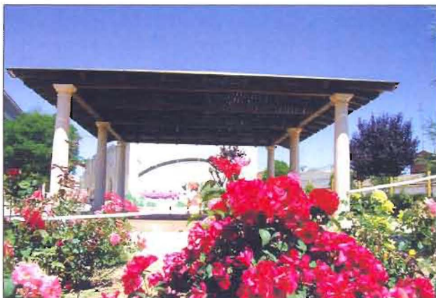
AULA AL AIRE LIBRE (EN OBRAS)
