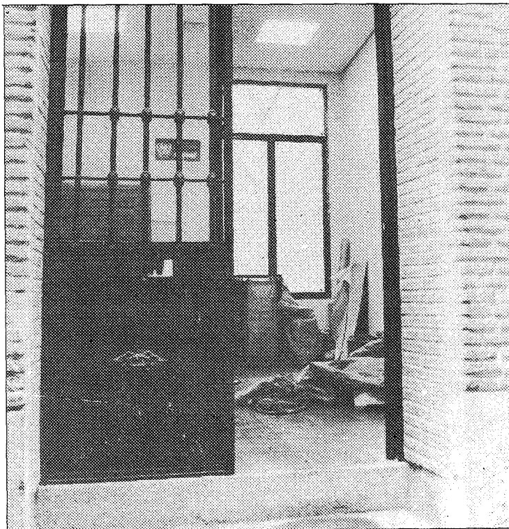
Después de 18 meses de trabajos, las obras de remodelación de Correos están aún sin terminar. (Foto: Carlos Moreno)
