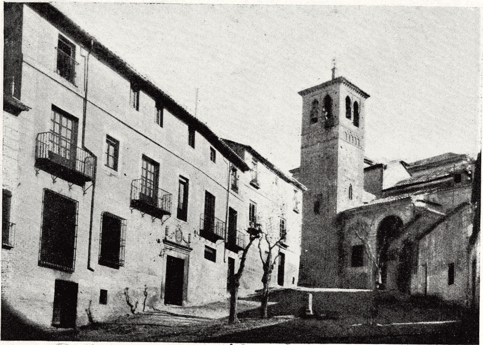
FACHADA DE LA HOSPEDERÍA
