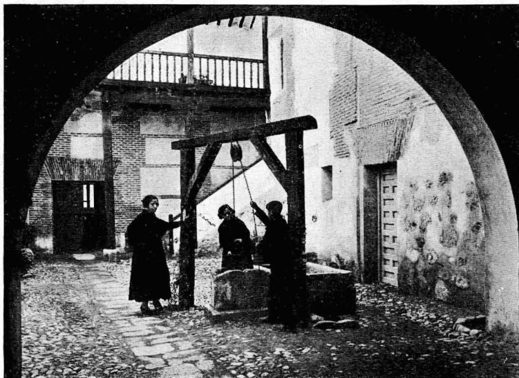
PATIO DEL POZO
