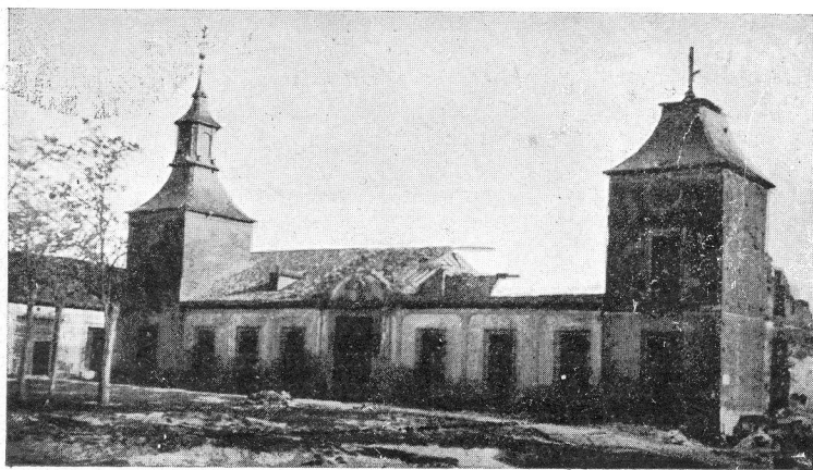
EL PALACIO EMPEZÁNDOSE A DERRIBAR
