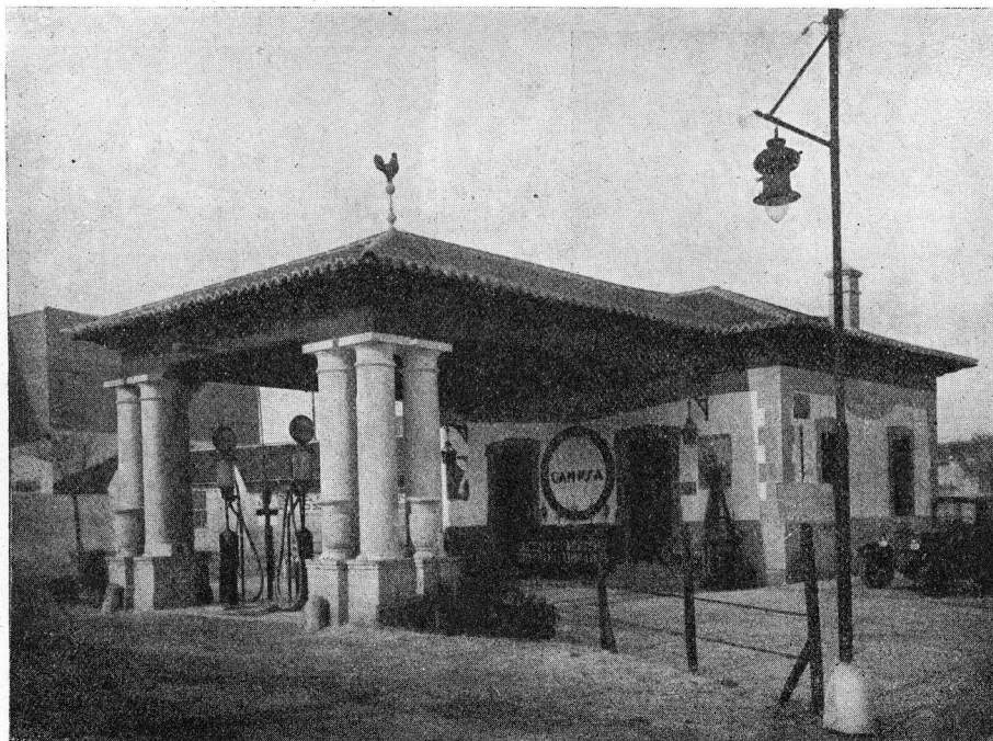
VISTA GENERAL DE LA ESTACIÓN
