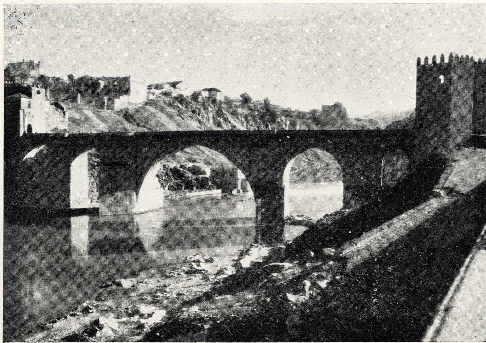
VISTA GENERAL DEL PUENTE
