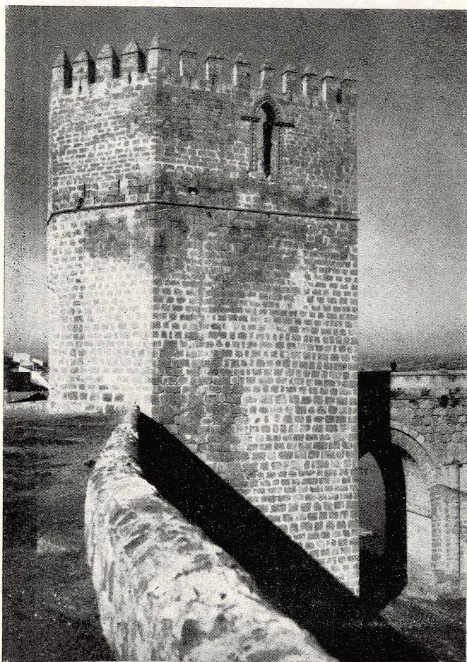
OTRO ASPECTO DE LA TORRE DESPUÉS DE LA RESTAURACIÓN
