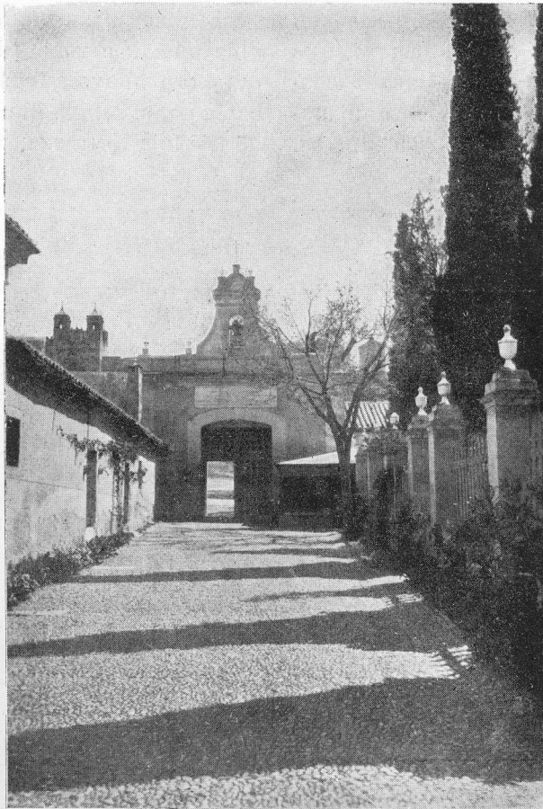
EN EL PATIO EMPEDRADO, LA DOBLE HILERA DE CIPRESES.....
