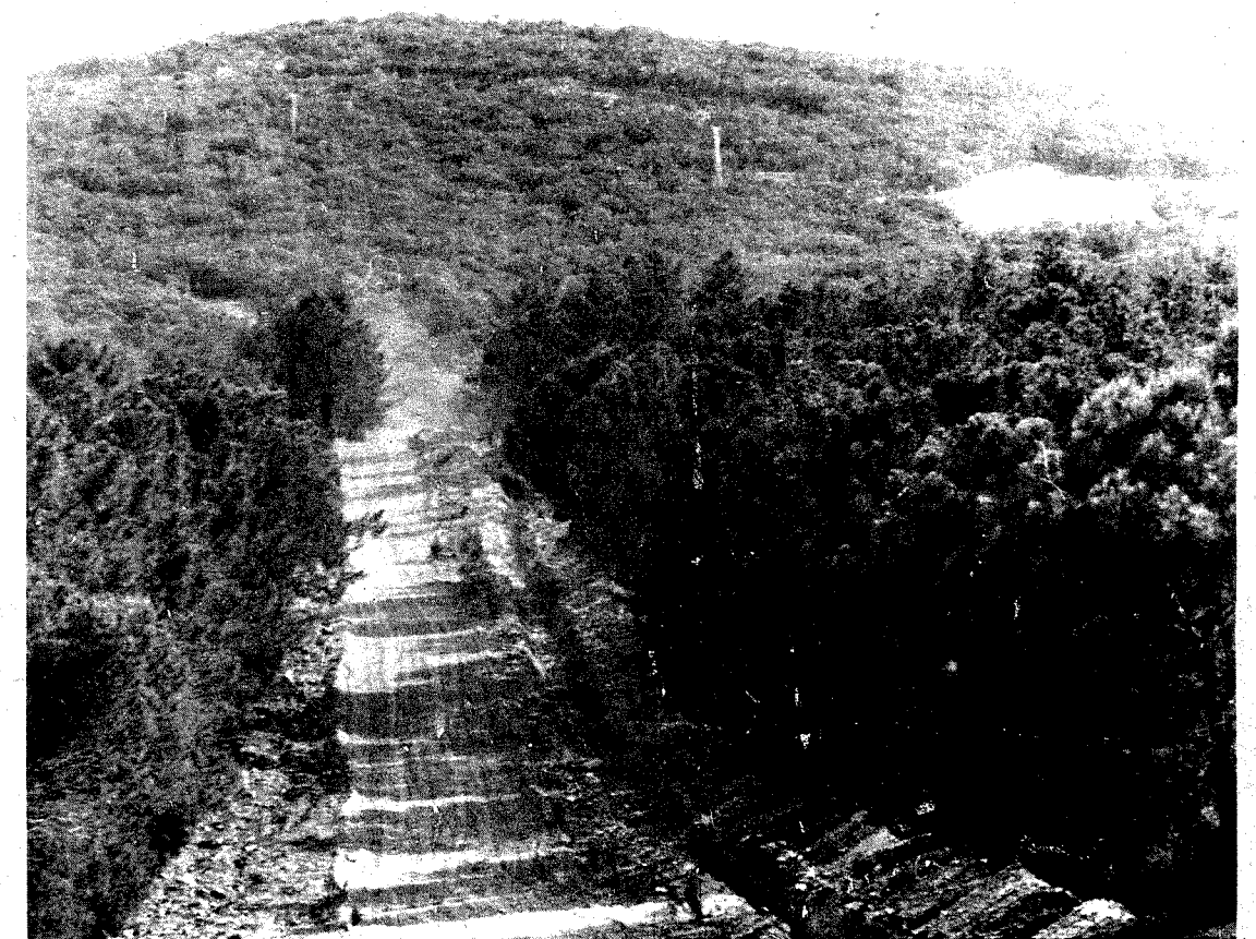
Camino que da acceso al túnel visible a la derecha de la fotografía. Para hacerlo ha sido necesario cortar una gran cantidad de pinos.
