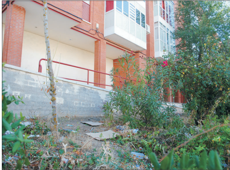
Edificio de las 99 en C/ Fresnedoso
