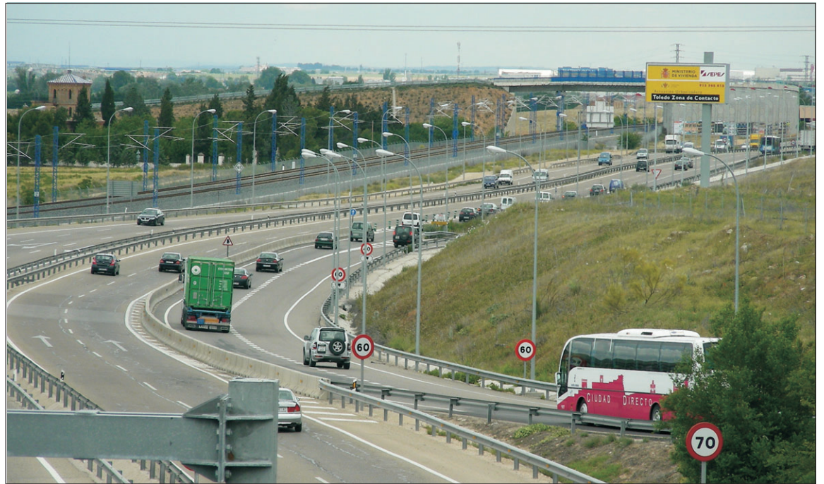
El apagón de la N-400 es un peligro para conductor y viandantes.
