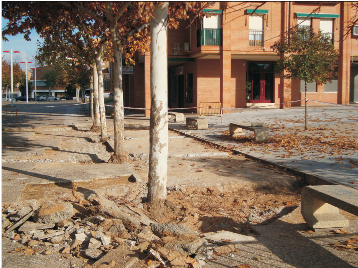
Obras para reposición de baldosas en el Paseo Juan Pablo II.
