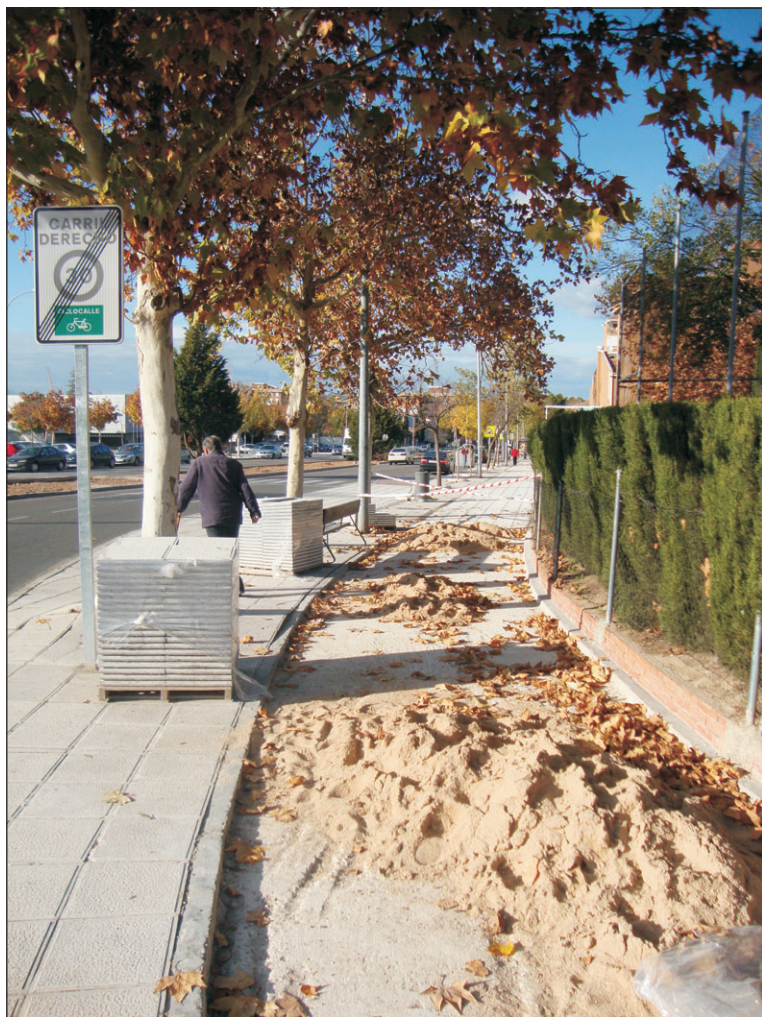
Nuevo acerado en una de las zonas de Avda. Guadarrama.
