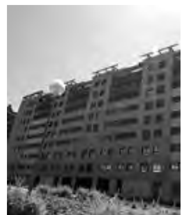
Viviendas en construcción. /E. de G.
