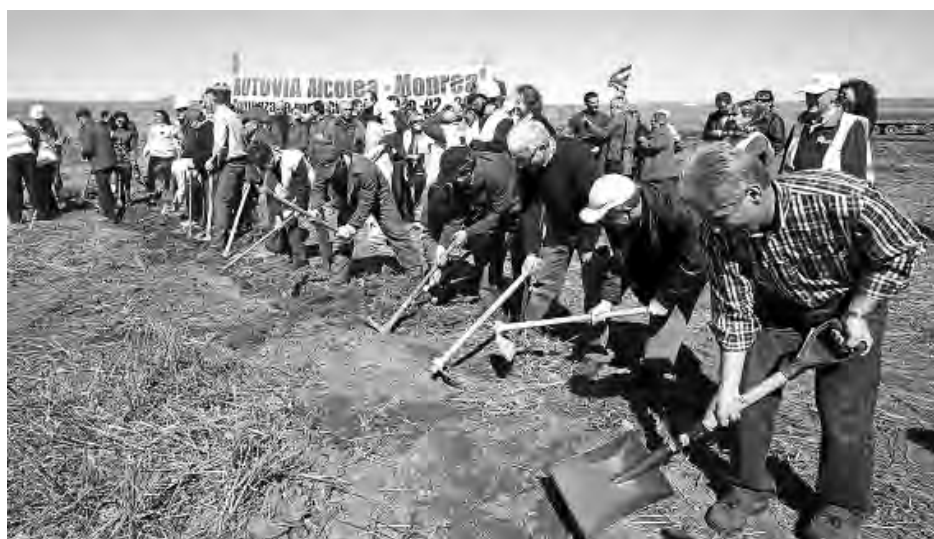
Los vecinos comenzaron unas obras que ven necesarias para su desarrollo. /Economía de Guadalajara
