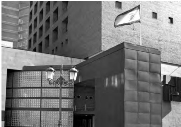
Fachada principal del edificio del CES. / Economía de Guadalajara
