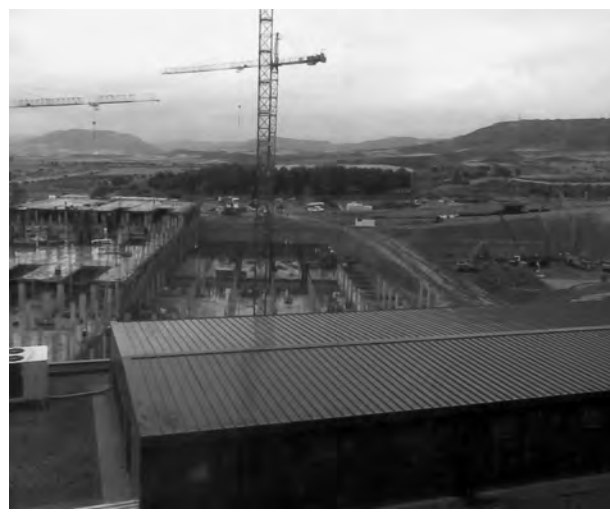
El hospital de Guadalajara es uno de los que ha parado sus obras. / E. de G.
