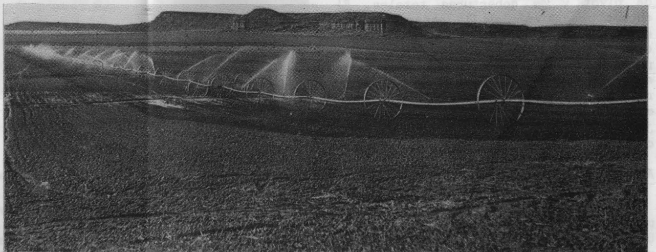
Sistema de aspersión autodesplazable RODIMATIC. Limitado a cultivos de una altura de porte inferior a 1 m.
