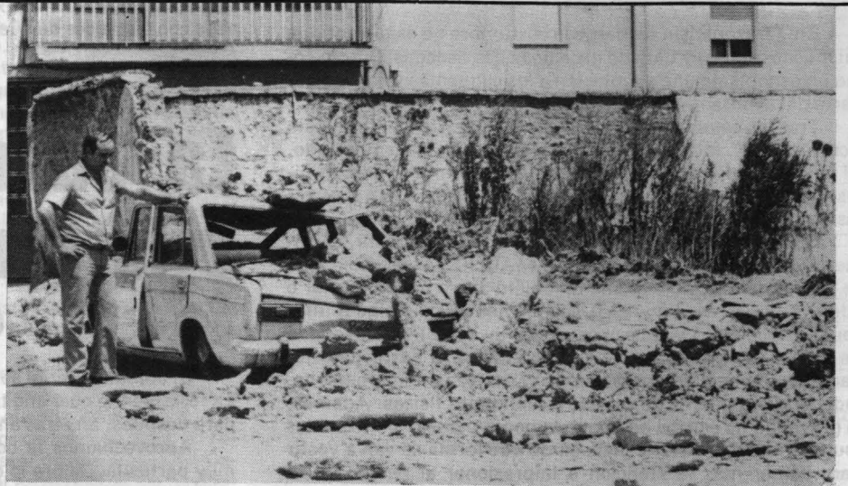
SUCESOS: El coche de Luis Sevilla, se vió afectado por el derrumbe de la tapia de la antigua verbena.
