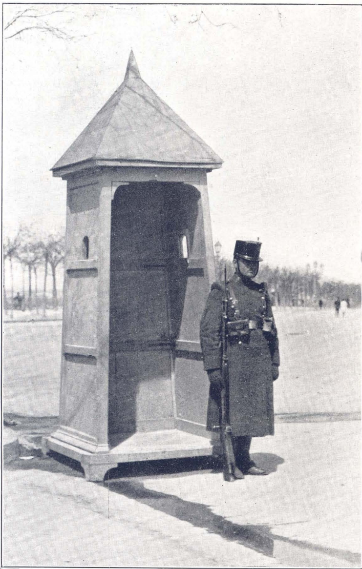
El mismo cliché ampliado con la Ampliadora Kodak «Auto Focus» a algo menos de 2 1/2 diámetros.
