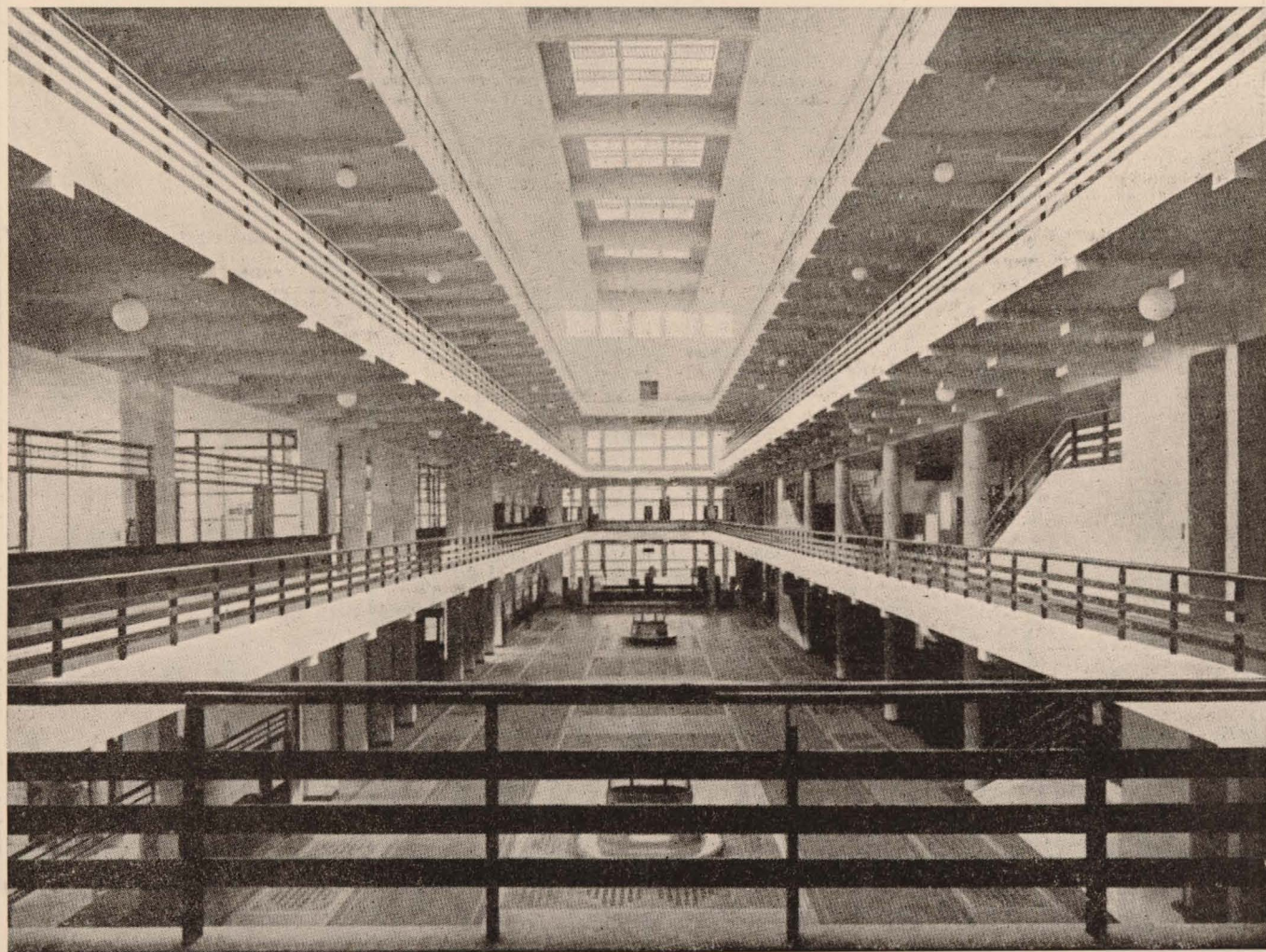
Nave central del Ayuntamiento de Boulogne - Billancourt.
