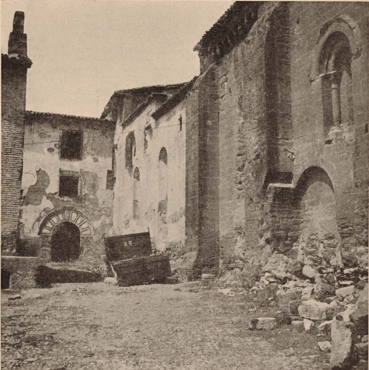
Escalera del palacio prioral, destruida.
