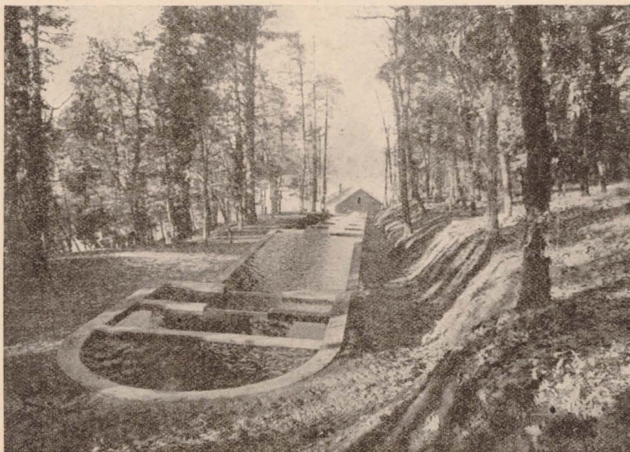
Cascadas, con sus filtros correspondientes, y estanque para alevines mayores, construidos en el exterior de la Piscifactoría.
