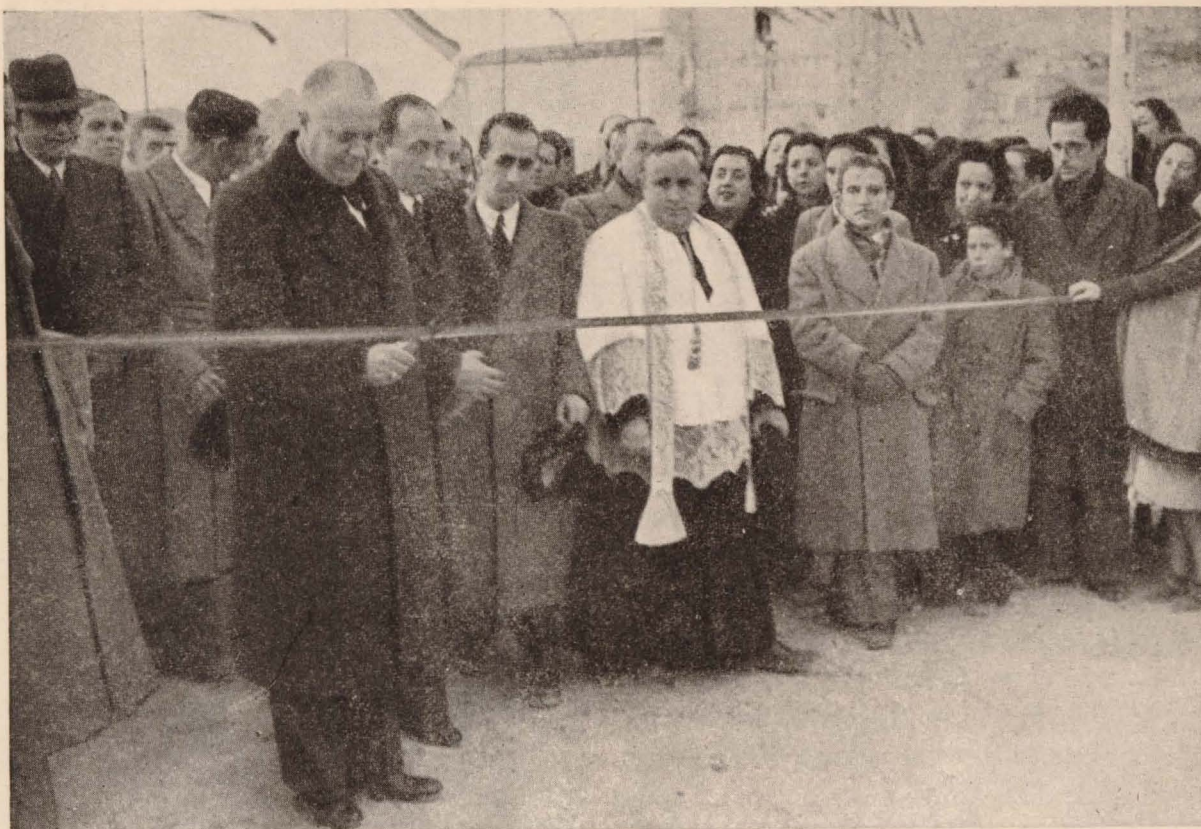
El Ministro de la Gobernación, Sr. Galarza, inaugura un bloque de viviendas en Titulcia. Abajo: Detalle de una de las viviendas.
