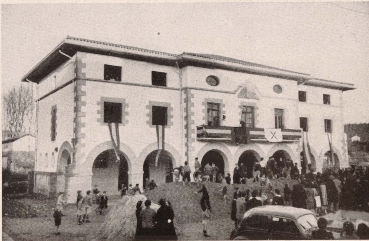
Amorebieta: Nuevo Ayuntamiento. Proyecto del arquitecto Emiliano de Amann. Inauguración del nuevo edificio.
