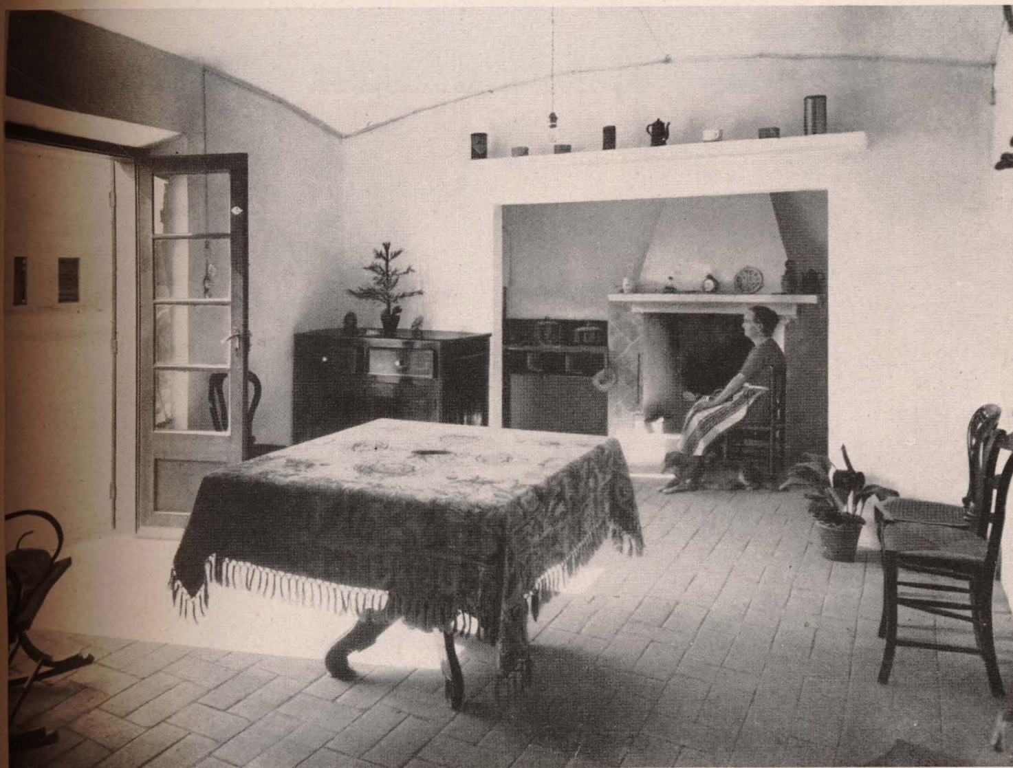
LLERS. Comedor-cocina de una vivienda tipo B.
