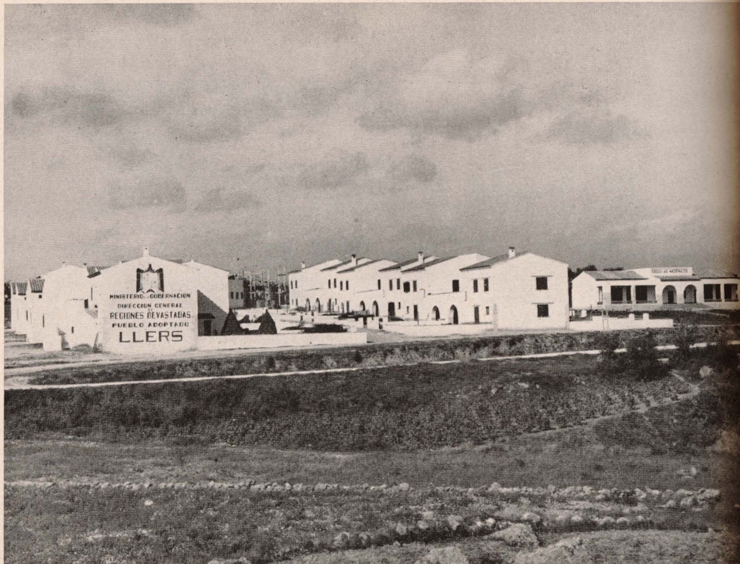
LLERS. Vista panorámica desde la carretera de Figueras a Albañá, de los dos grupos de casas terminadas y el Grupo escolar. Al fondo, el Grupo parroquial, en construcción.
