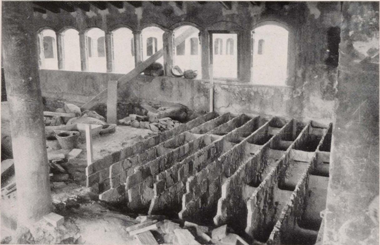
*Aligeramiento de las bóvedas. Abajo: Apeo de arcos para la reparación de pilastras.*
