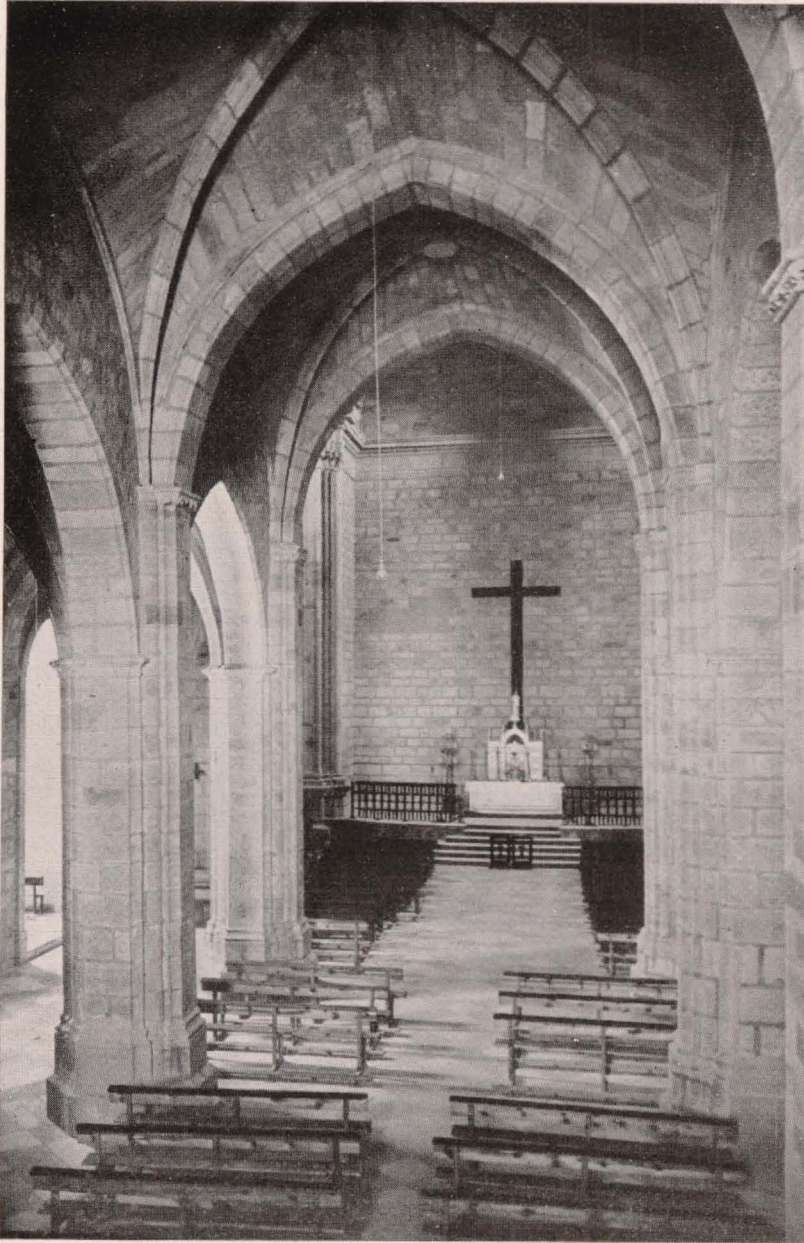
LINARES.—Iglesia de Santa María. Vista del interior desde el coro, después de haber sido descubierta la piedra oculta del revoco.
