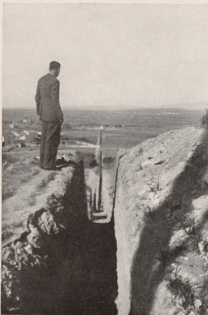
AGRAMUNT.—Tubería de impulsión; al fondo, los depósitos de reserva. A la derecha: la tubería vista desde la caseta de elevación, y al fondo, el depósito regulador número 1.
