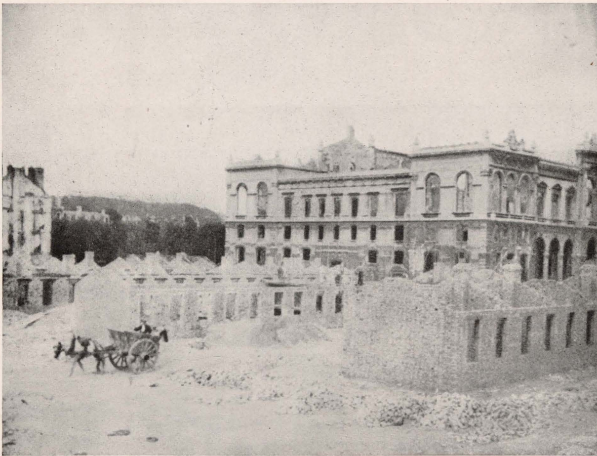
Obras de reconstrucción y descombro en la ciudad de El Havre.
