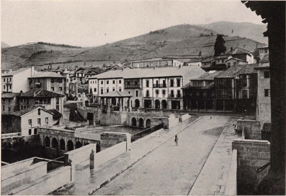
POTES.—Conjunto del puente, mercado y viviendas particulares.
