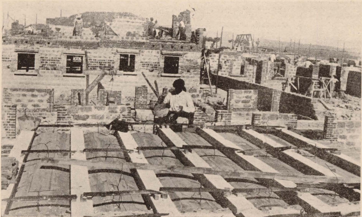
Fig. 15.— Encofrados para el tendido de bovedillas en Brunete.
