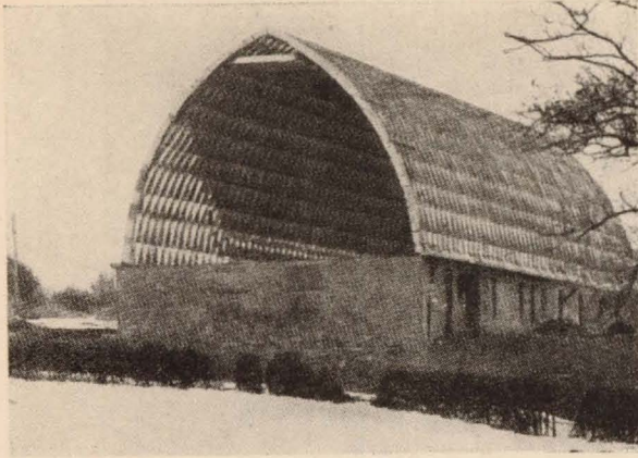
Figuras 40 y 41.—Solución de bóvedas reticuladas con rasillas dobles colocadas a panderete y tabicadas con hoja interior y exterior del mismo material, al alcance de cualquier medio rural.
