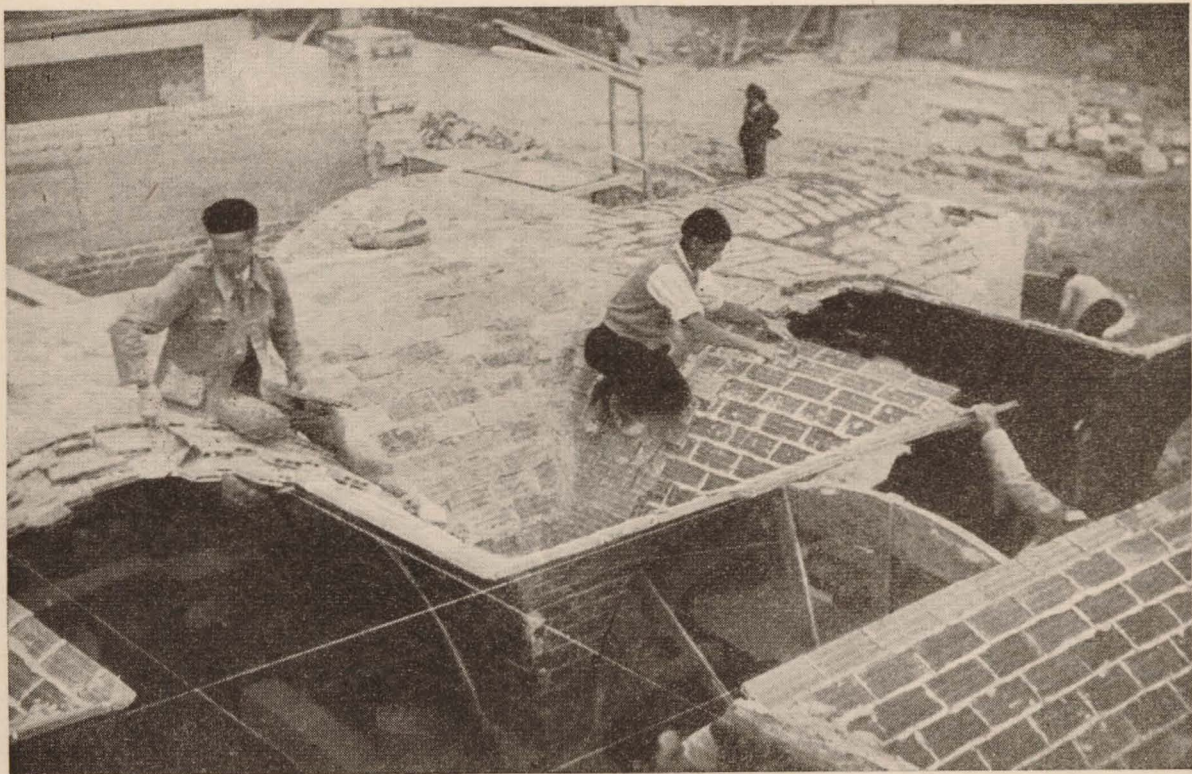
Fig. 28.—Bóvedas tabicadas por arista, en Villanueva de la Cañada.
