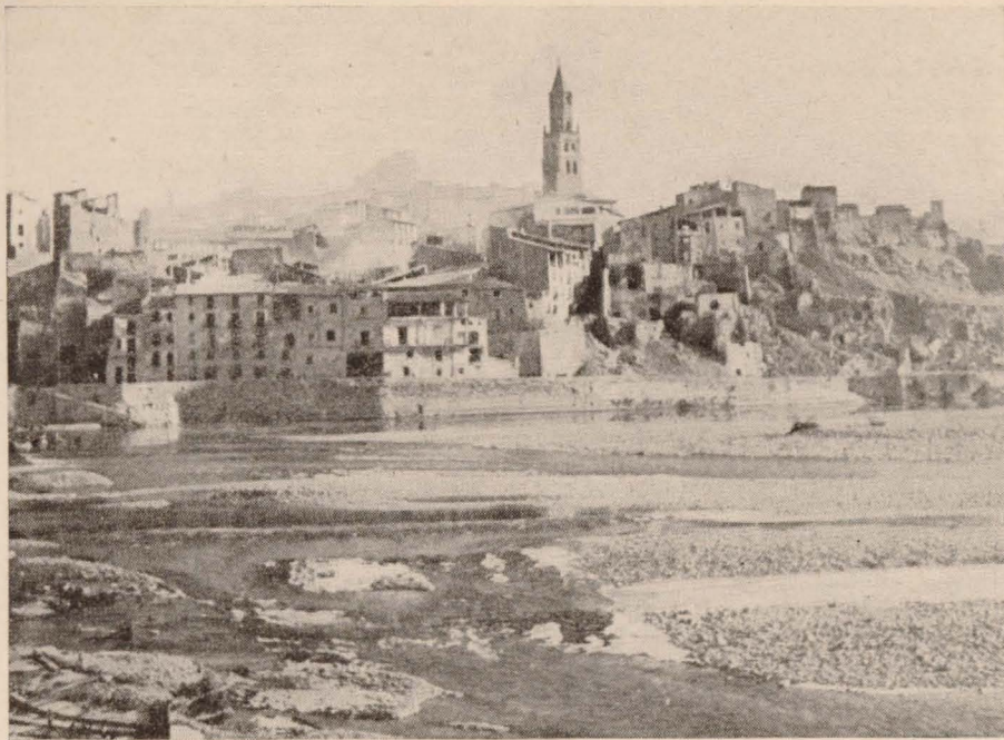
Fig. 1.—Fraga, emplazado sobre estratos de arcilla, que deslizan lentamente hacia el río.
