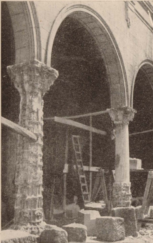
Fig. 12.—Capiteles, columnas e impostas vaciadas de piedra artificial, en la Iglesia de Munguía.
