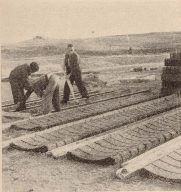
Fig. 16.— Construcción de bloques para bovedillas
