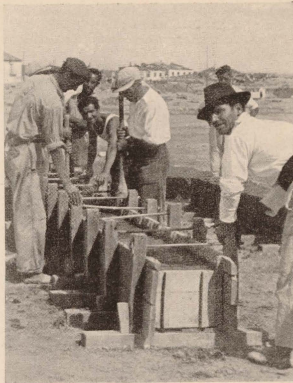
Fig. 6.—Fabricación de grandes adobes en Brunete
