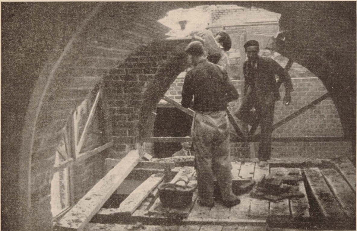
Fig. 26.—Construcción de bóvedas tabicadas en Villanueva de la Cañada.
