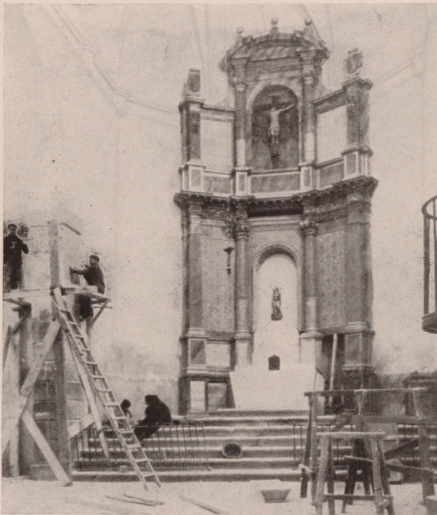
Obras de reconstrucción de la Iglesia parroquial, habilitada, en parte, para el culto.
