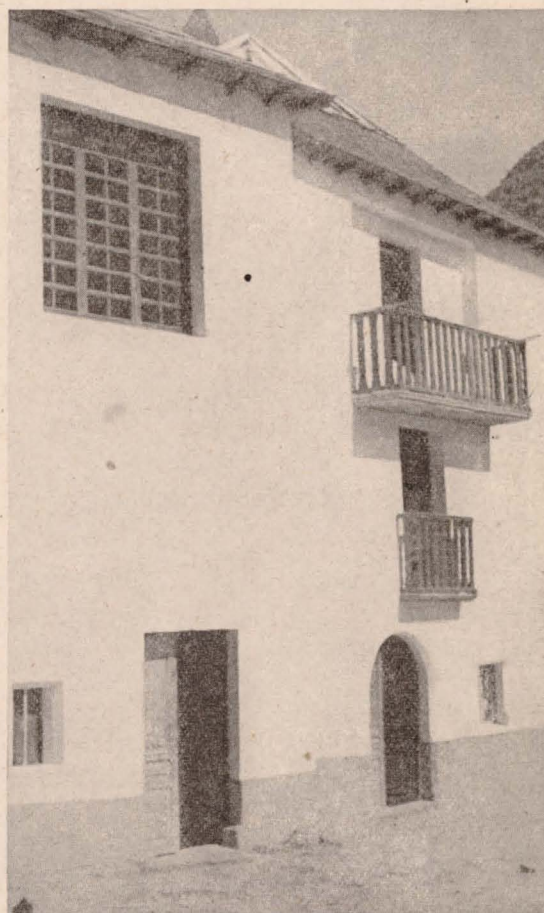
Viviendas habilitadas de BROTO
