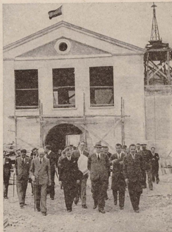
El Ministro de la Gobernación inspecciona las obras de reconstrucción de Guernica (a la derecha) y Nules.
