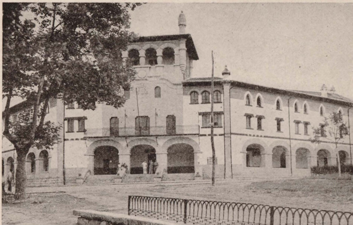
Ayuntamiento reconstruido. MUNGUIA
