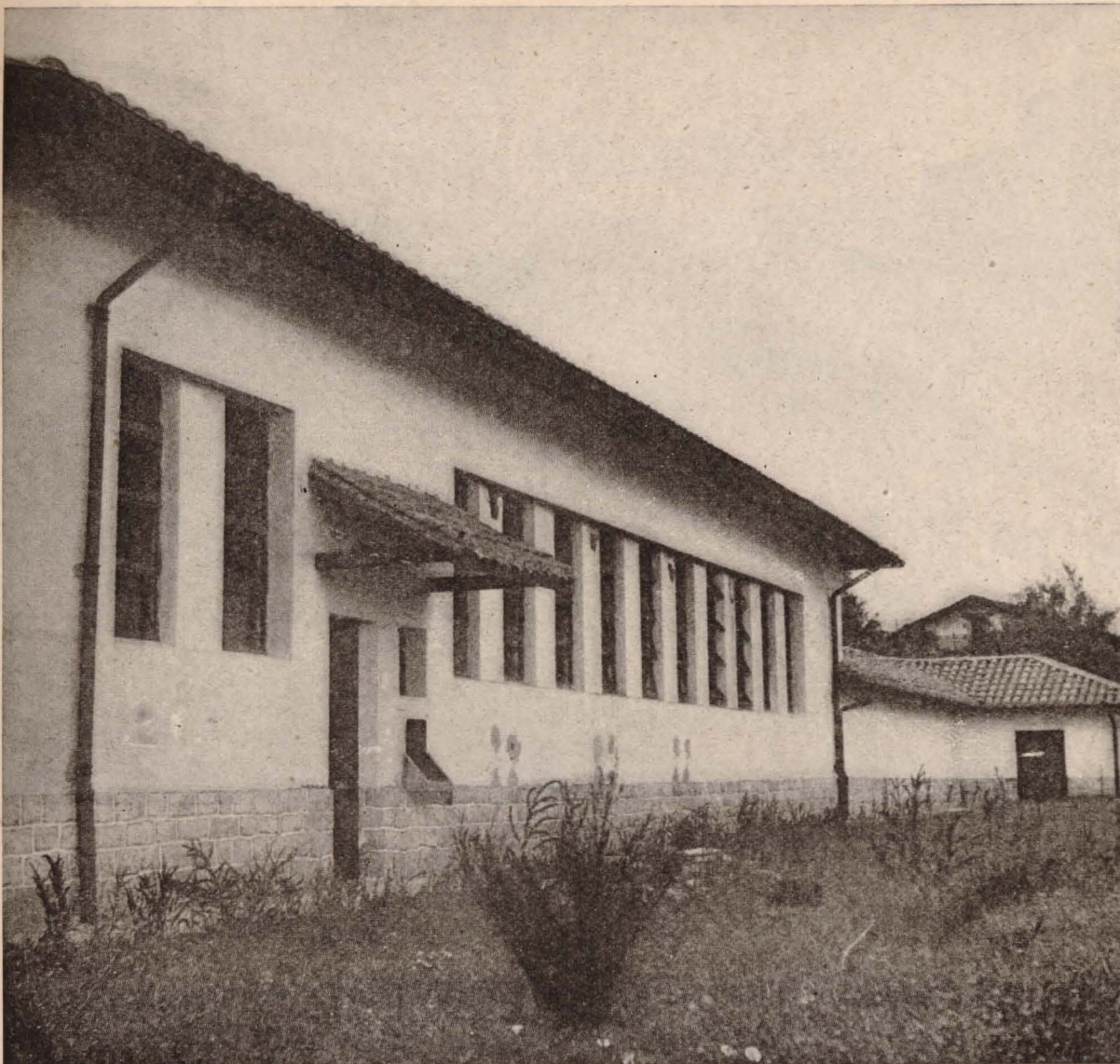
Matadero de nueva planta. AMOREBIETA
