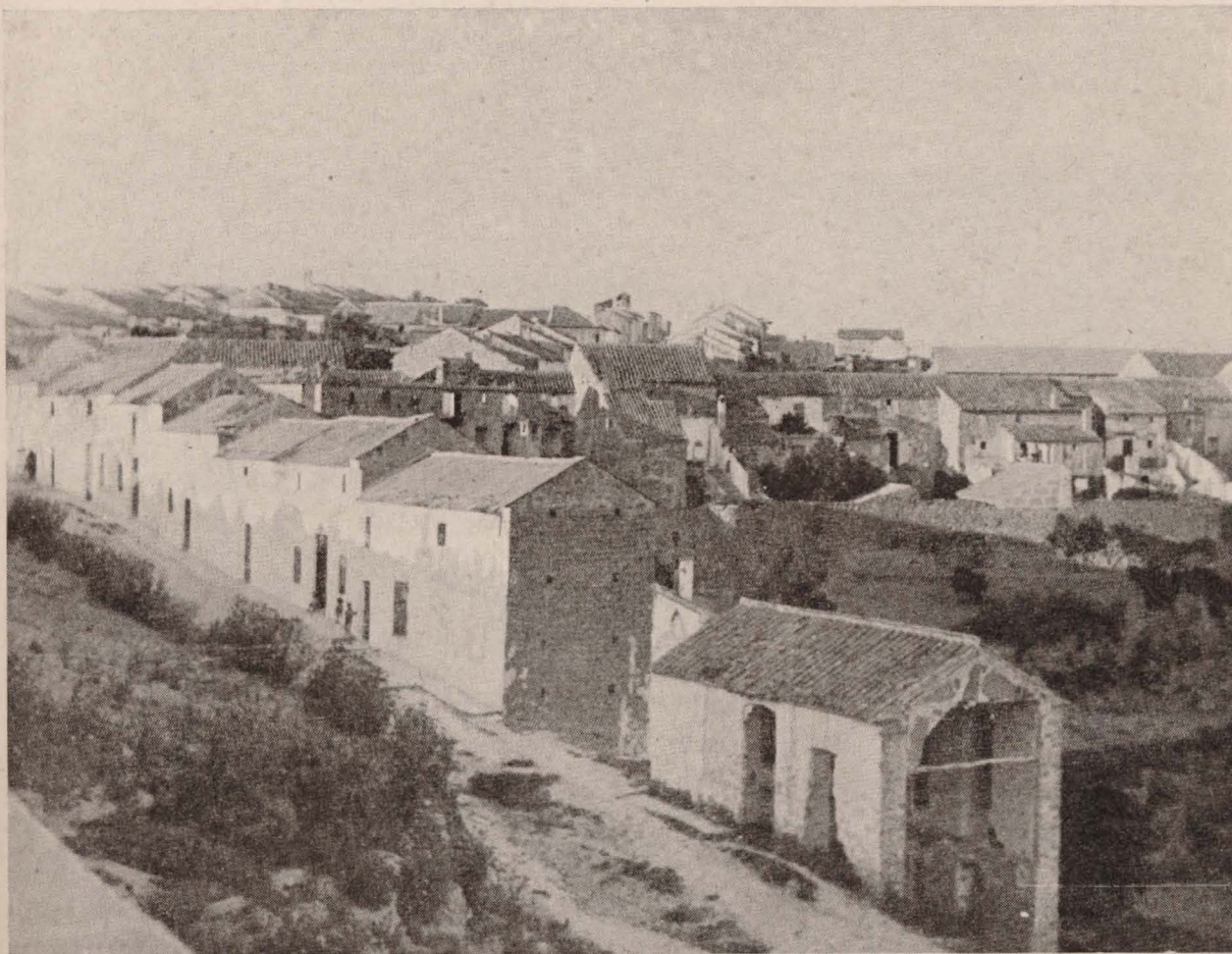
Viviendas habilitadas. PORCUNA
