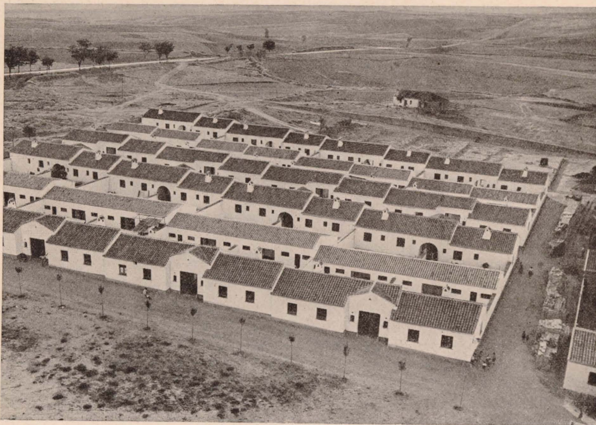
Viviendas de nueva planta. LAS ROZAS
