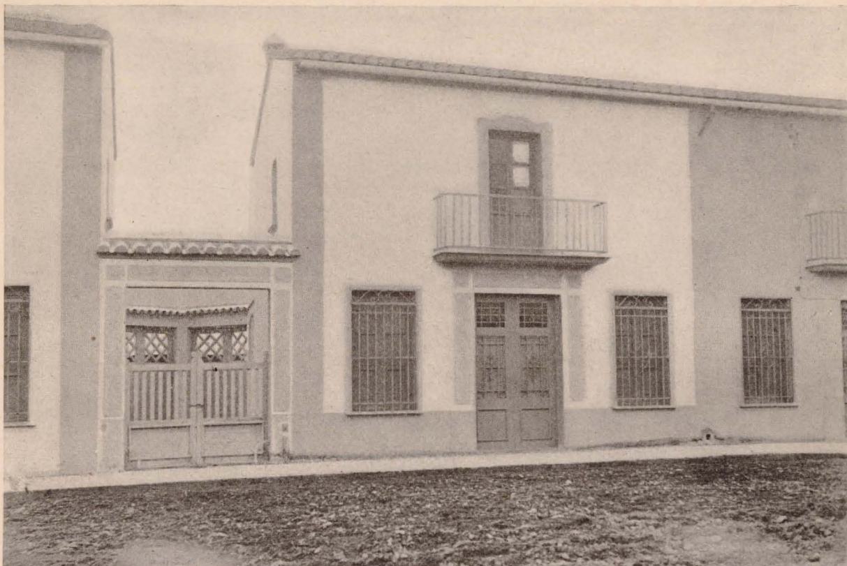
Viviendas de nueva planta. NULES
