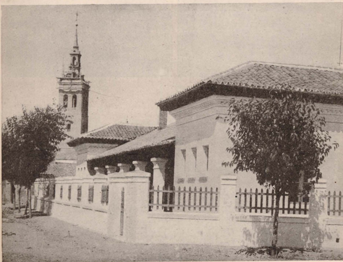
Escuelas reconstruidas de SAN MARTIN DE LA VEGA
