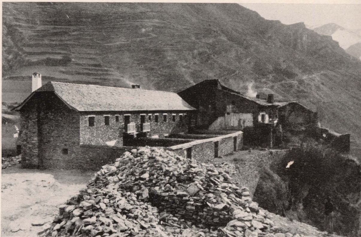
TIRVIA.—Viviendas de nueva planta.
