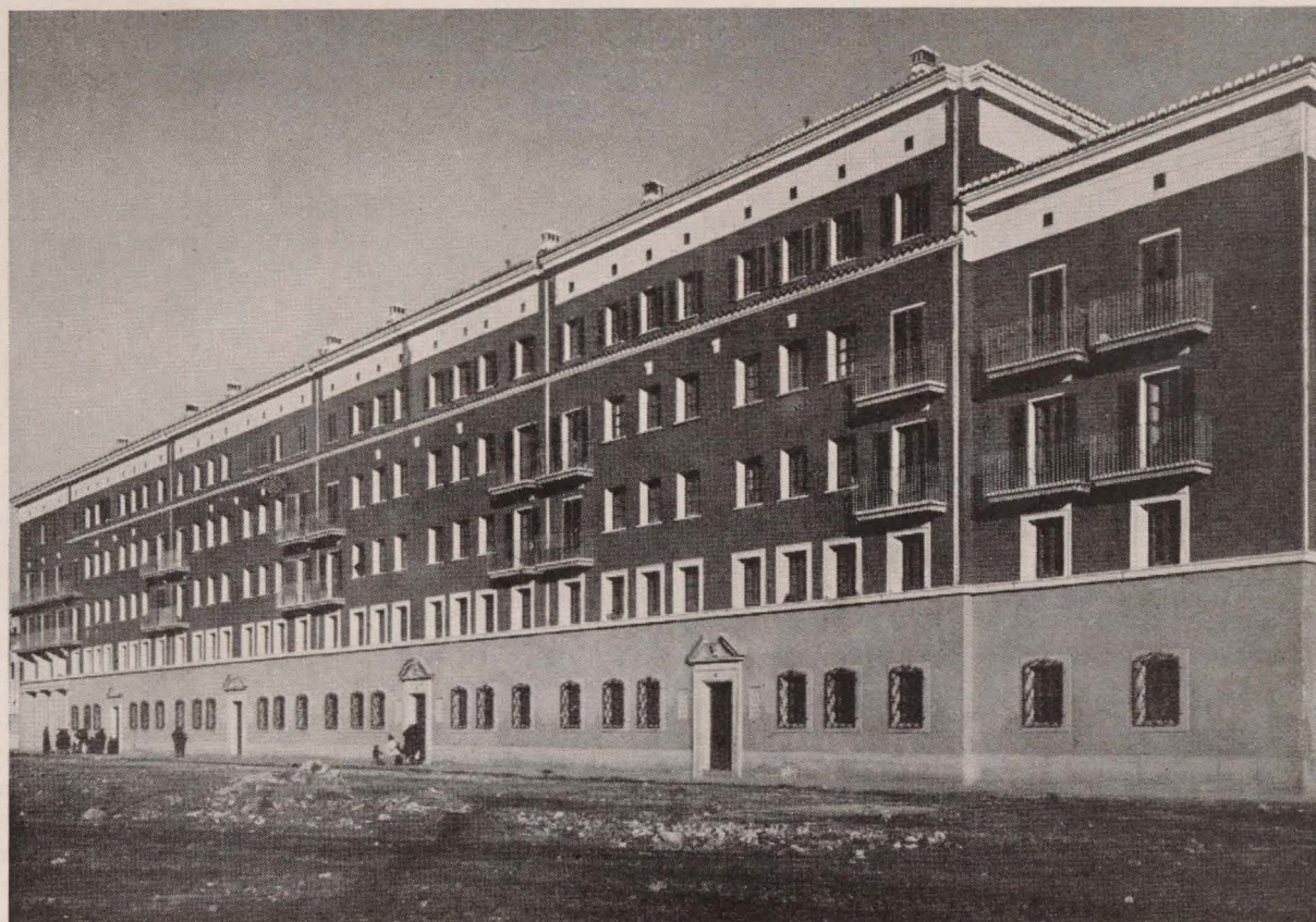
VALENCIA.—Poblados marítimos. Segundo grupo de viviendas urbanas. Fachada principal.
