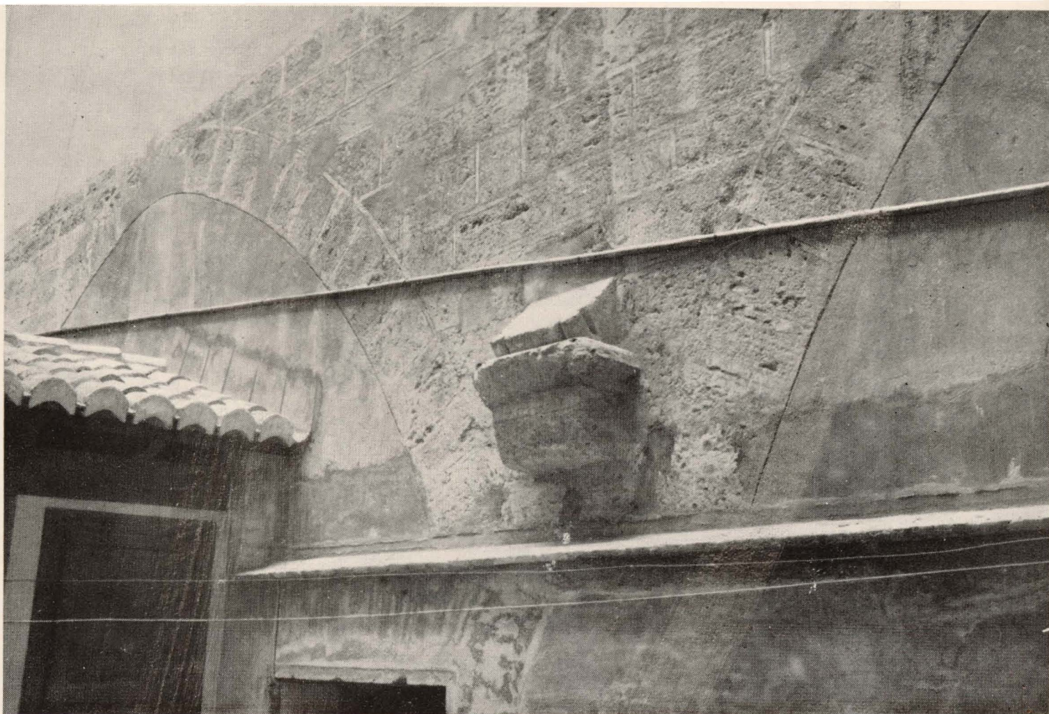
Restos de la obra gótica con el arranque de un arco.
