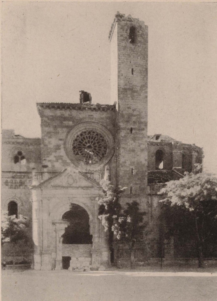
Fachada, puerta, torre y parte del ábside, hundidos. (Foto "Ediciones Españolas".)
