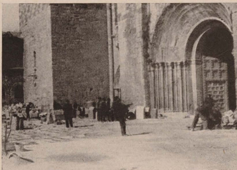
Reconstrucción: Fachada Oeste, en pleno trabajo.
