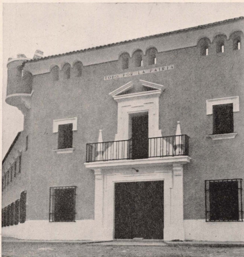
HIGUERA DE CALATRAVA.—Cuartel de la Guardia Civil. Detalle de la fachada.
