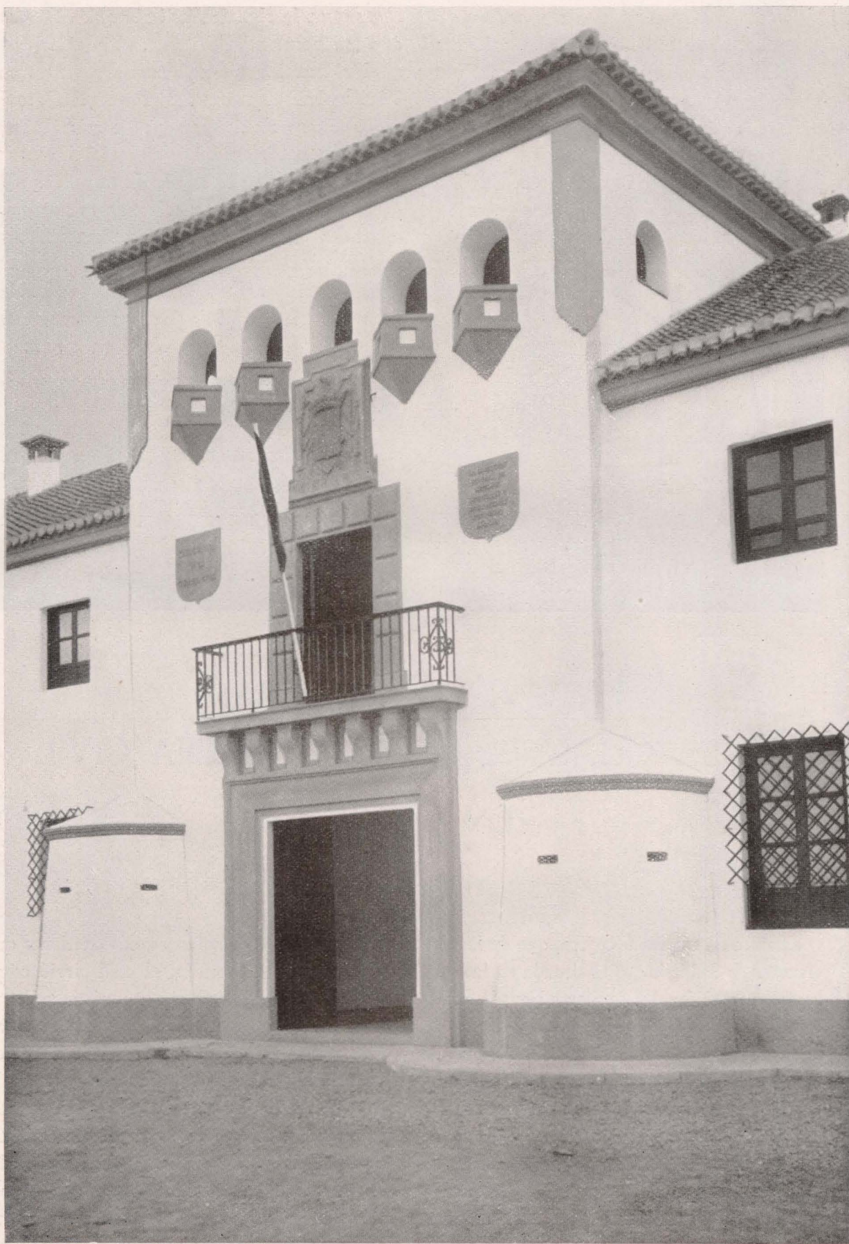
Fachada principal. Detalle.
