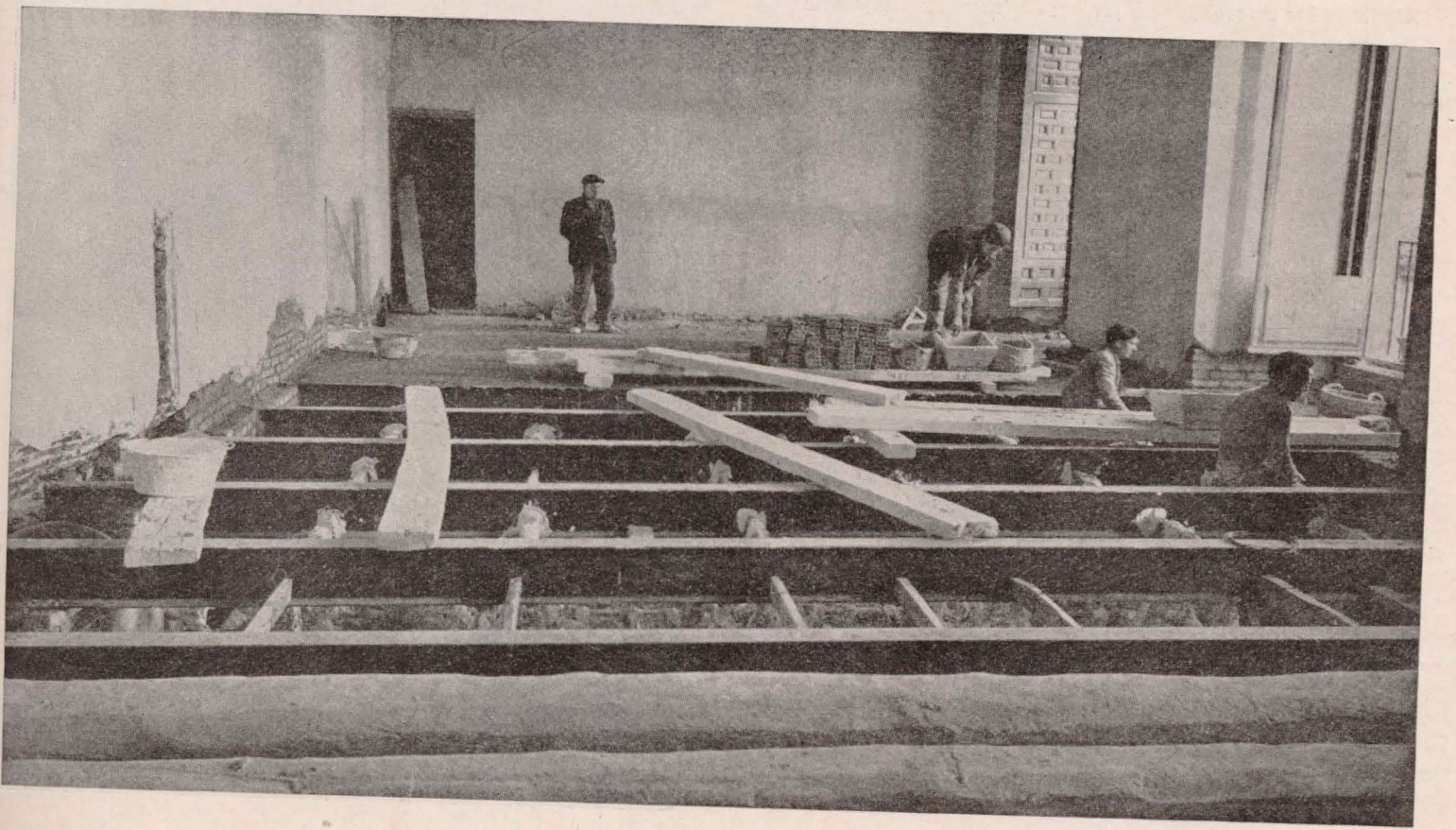
Estado de la sillería de fachada, antes y después de la reconstrucción. Abajo: Sustitución de las vigas de madera por perfiles metálicos.
