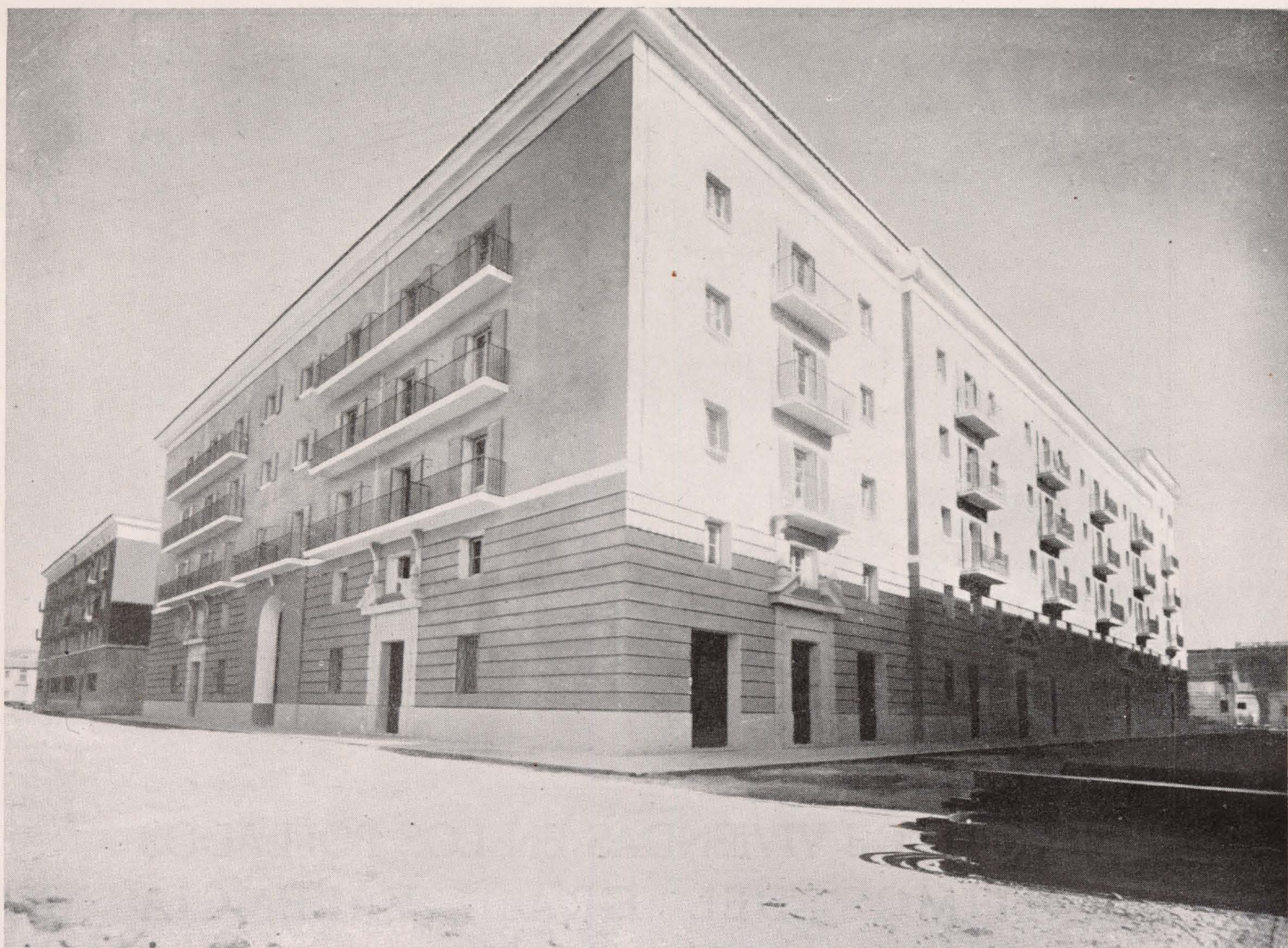
VALENCIA.—Poblados marítimos del Grao. Tercer bloque de viviendas. Vista de las fachadas posterior y Levante.
