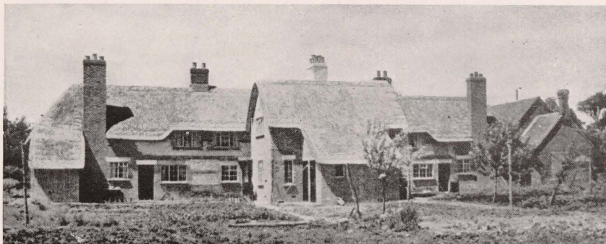
Casa de campo reconstruida. Fachada posterior.
