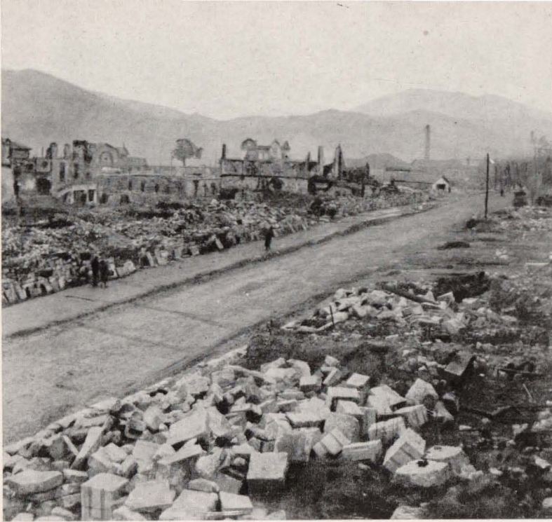
Estado actual de la explanación de Artecalle. (Foto Marqués Santa María del Villar.)
