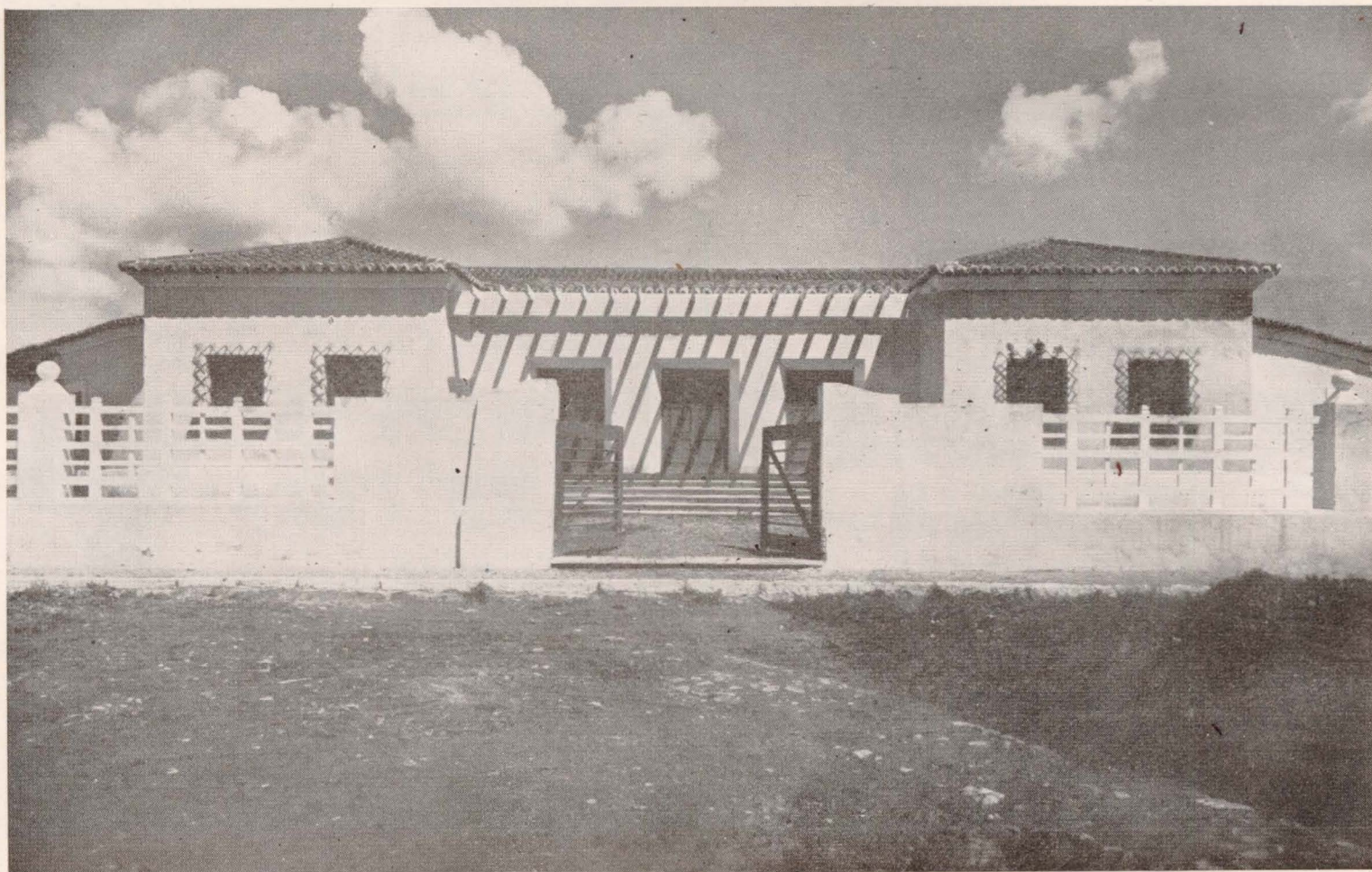
Grupo Escolar de La Granjuela. Fachada posterior.
