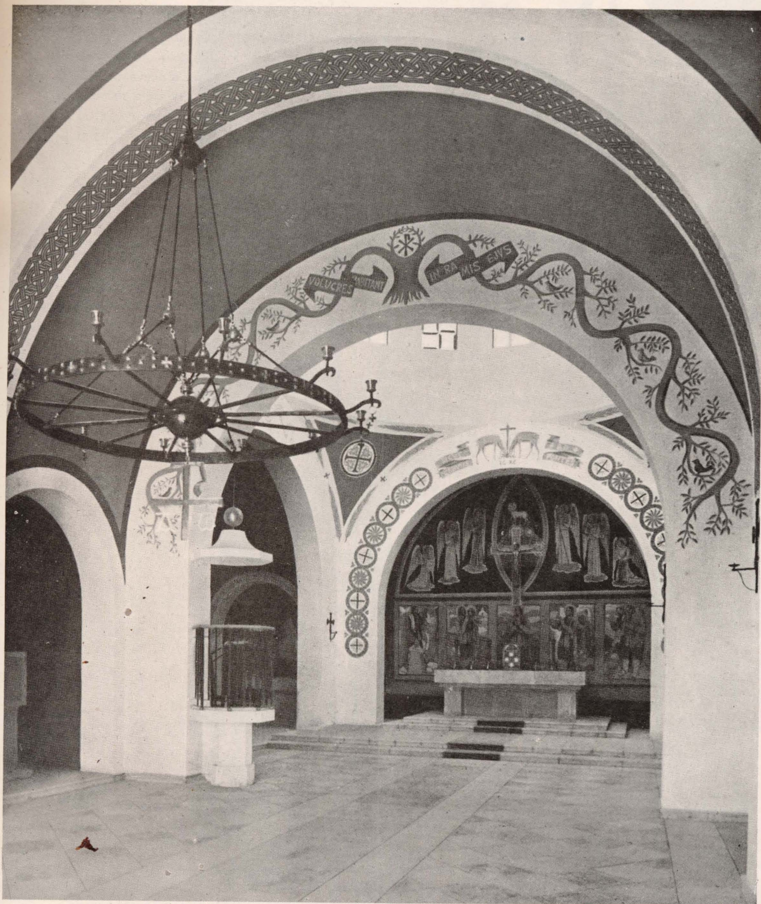
Interior de la Iglesia y detalle de las lámparas de hierro.
