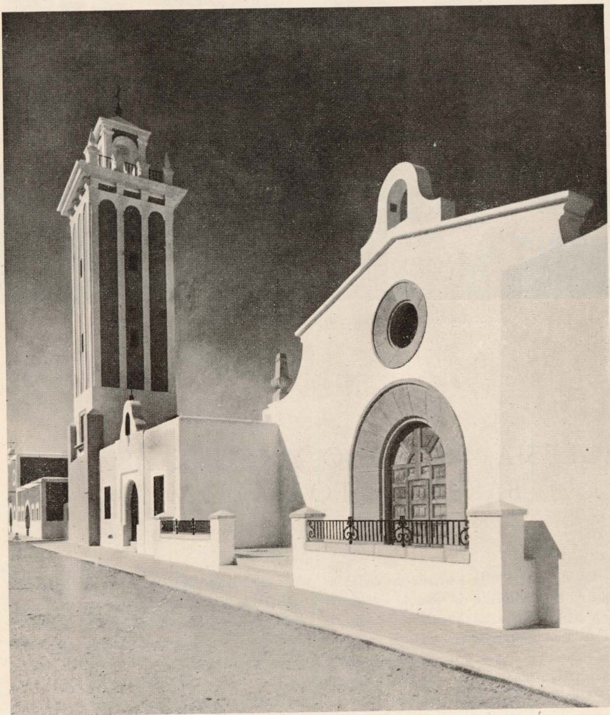
Detalle del imafronte y torre exenta.
