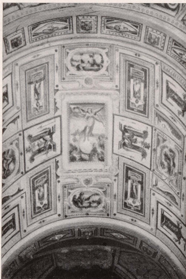
Bóveda de la escalera, decorada en estilo pompeyano.
