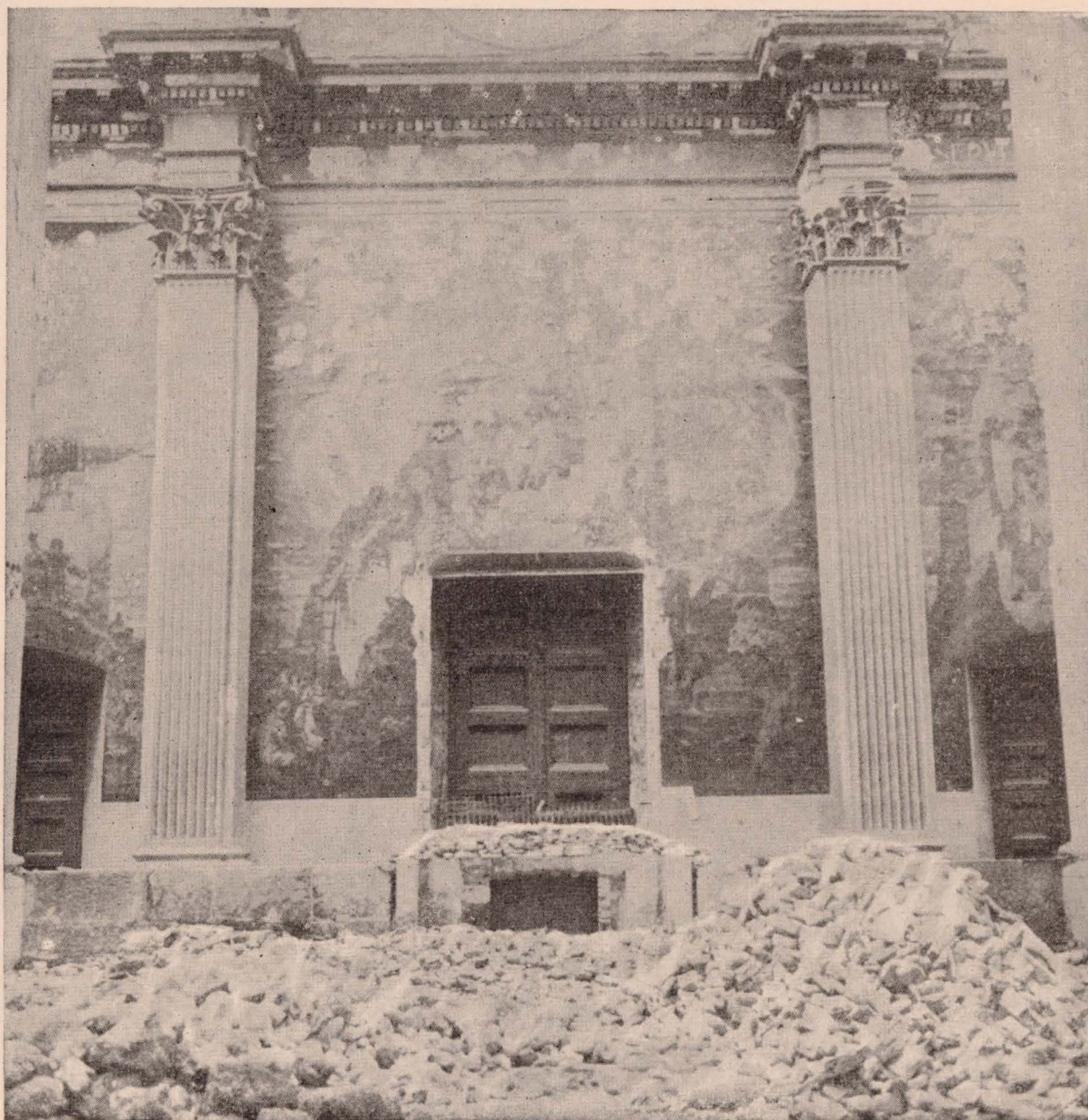
Catedral de Vich: las pinturas del triptico del muro de fachada, destruidas por el fuego.
