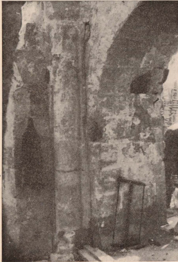
Torre del Santísimo: 1. Columnas descubiertas con los ventanales limpios. 2. Fábrica primitiva.
