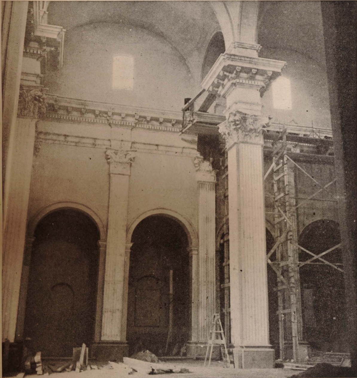
Las obras de reparación del interior del templo van rápidamente terminándose.
