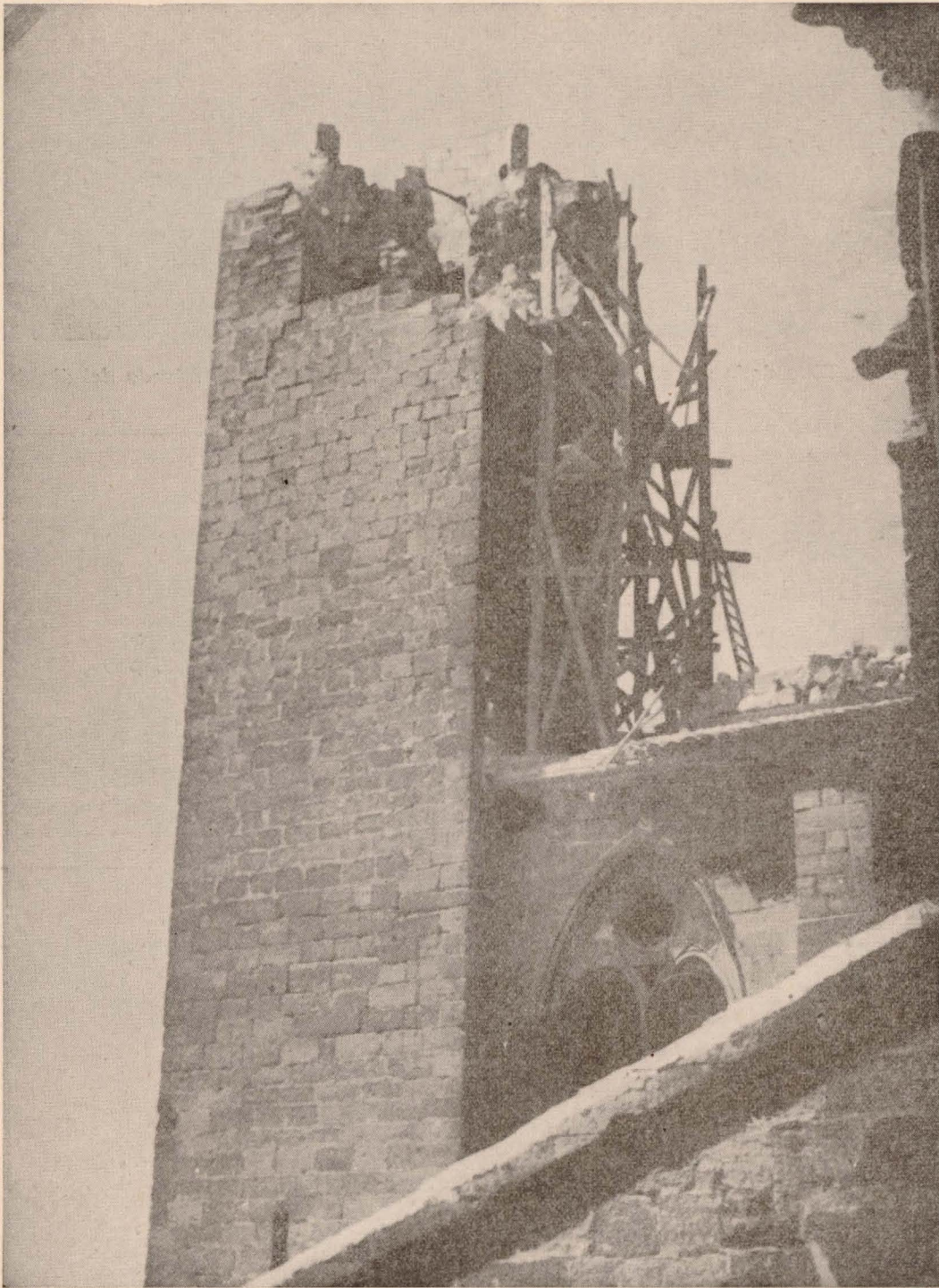
Torre del Santísimo, durante el descombro.
