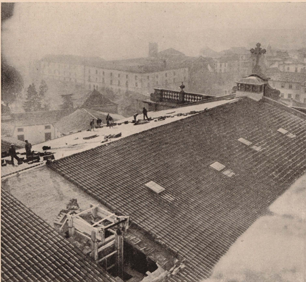
Se está terminando la cubierta. Recubrimiento de la solera con tejas del país. Fotografía tomada desde el campanario el 23 de diciembre de 1941.
