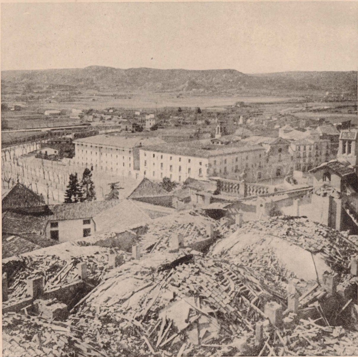
Estado en que quedó la cubierta de la Catedral. Fotografía obtenida en enero de 1937. Pueden apreciarse las grandes jácenas de madera rolliza completamente convertidas en carbón.
