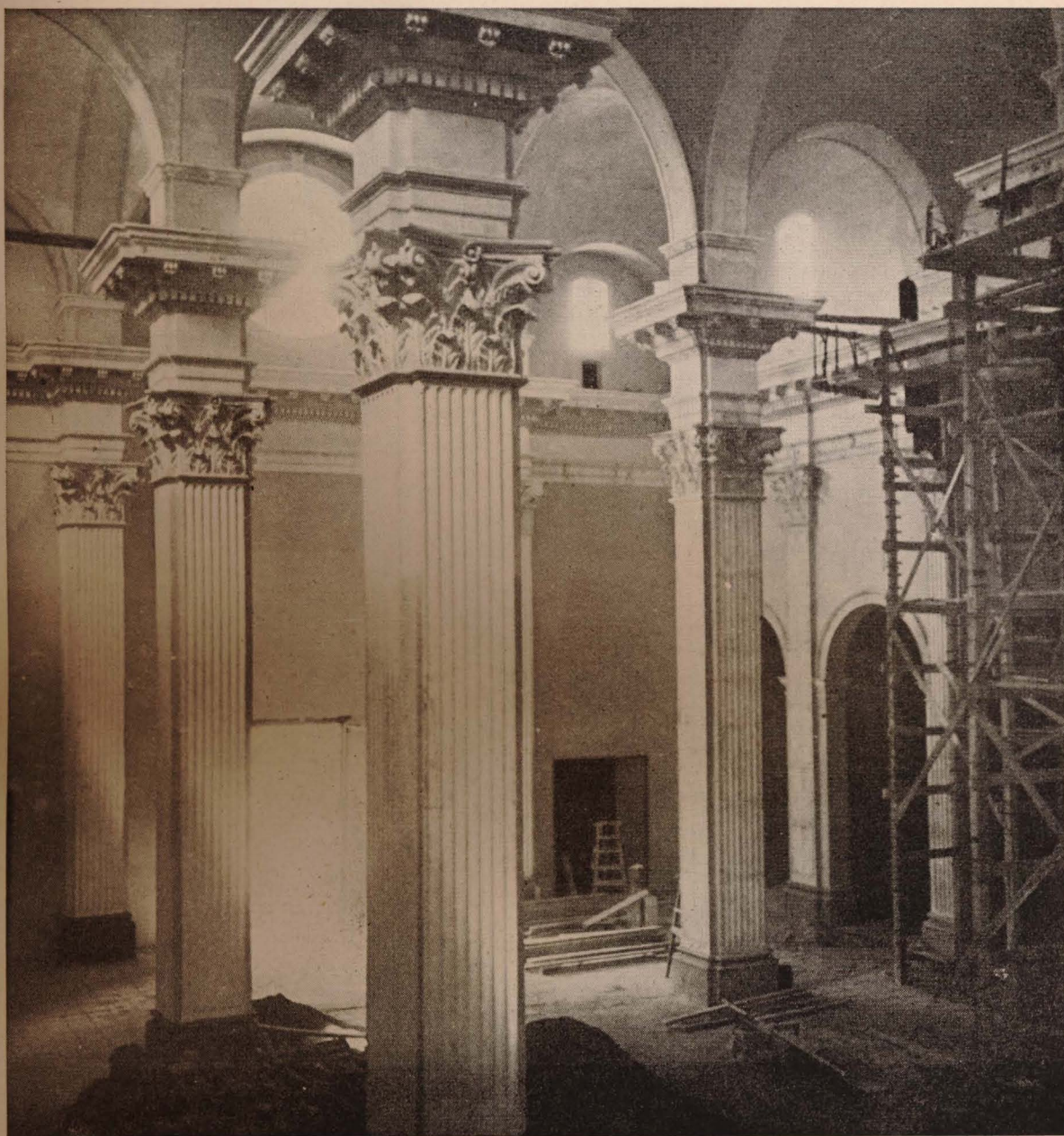
A medida que se desmontan los andamiajes, se presenta el limpio trabajo del yesero, y las acertadas proporciones de los elementos arquitectónicos de las pilastras aisladas.
