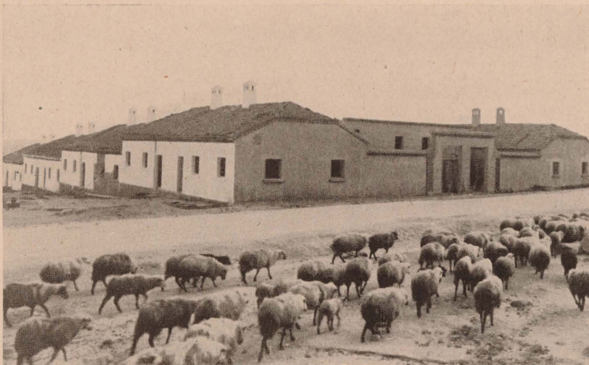
Majadahonda: Grupo de casas, totalmente terminado.
