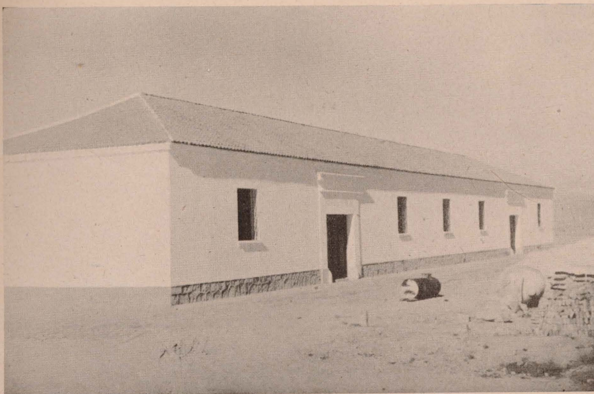
Villanueva de la Cañada: Panera Sindical.
