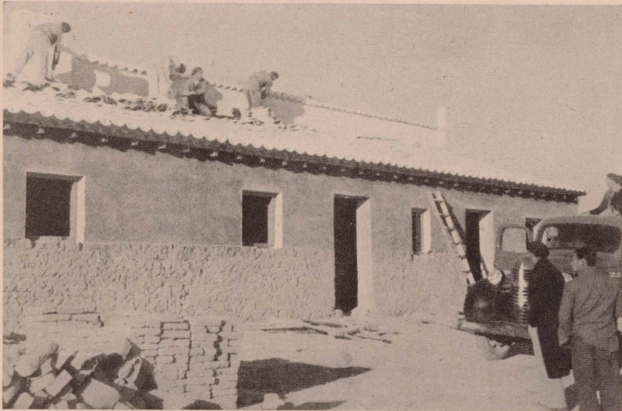
Masegoso: Trabajos de reconstrucción.
