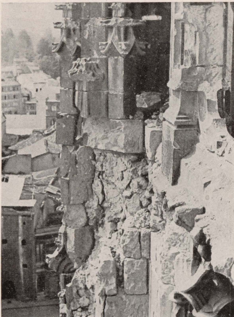
OVIEDO.—Catedral. Ruinas del contrafuerte del ángulo de la torre entre la plaza y tránsito de Santa Bárbara.
