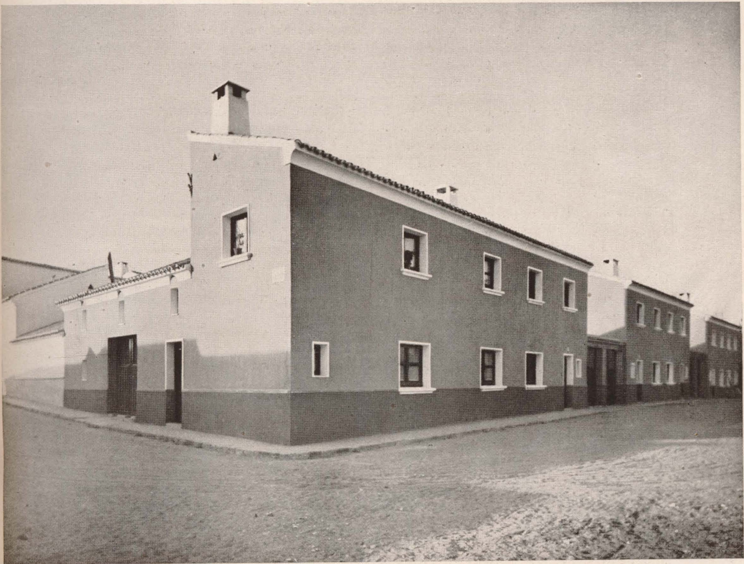
Primeras viviendas construídas.
