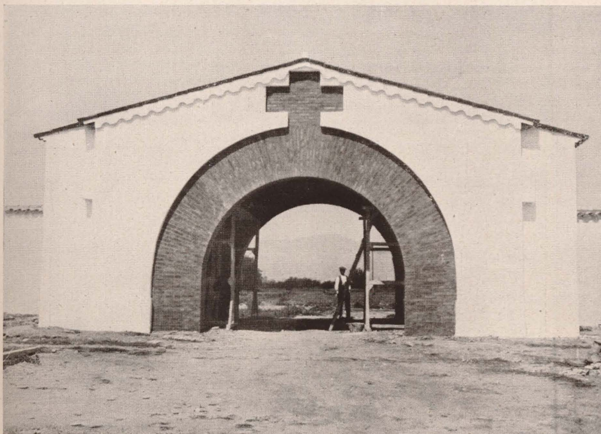
Moncófar: Obras del cementerio.
