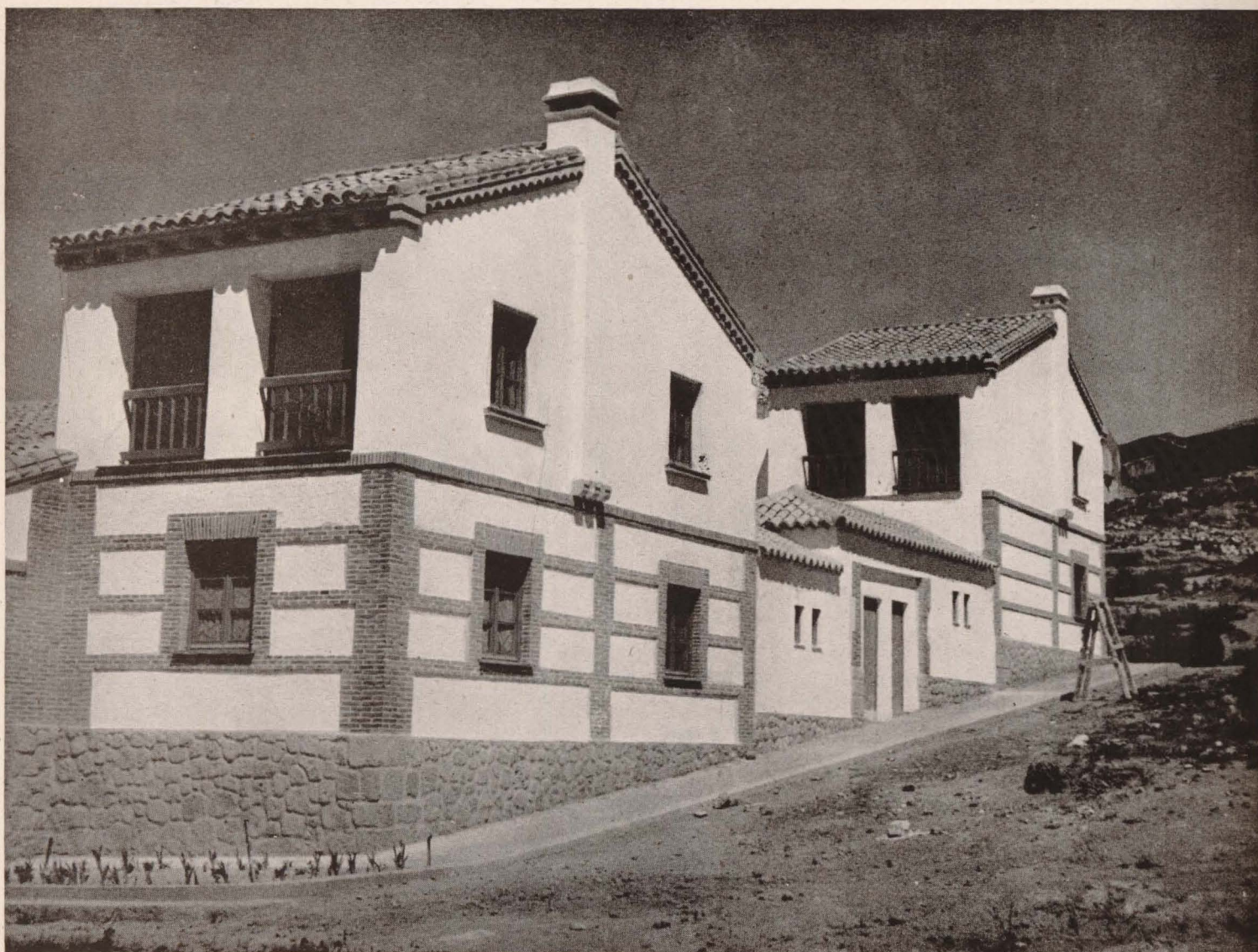
Detalle de la esquina de una manzana.
