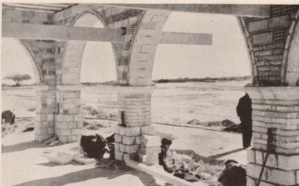
Belchite: Granja. Construcción de arcadas con ladrillo hueco.
