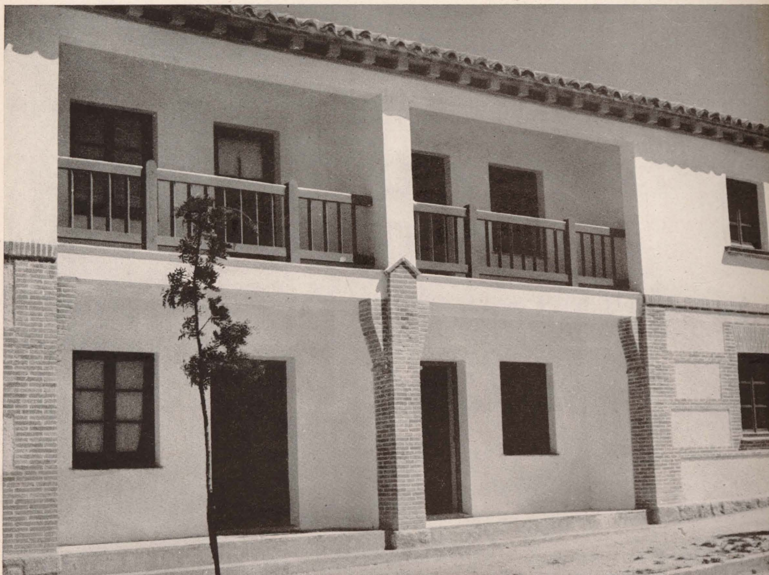
Fachadas de las viviendas tipo B.
