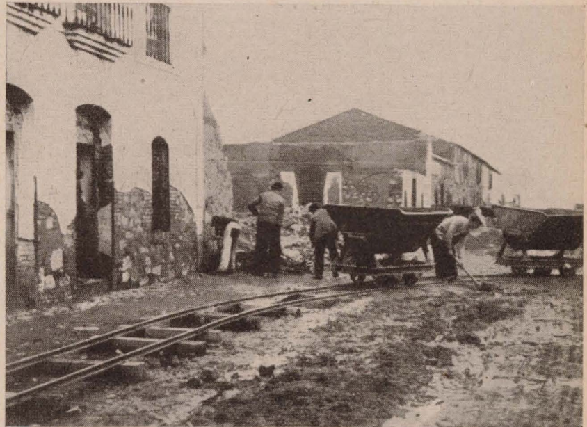
Trabajos de descombro en Los Blázquez. Arriba: Plaza Mayor. Abajo: Preparando el acceso a los nuevos grupos escolares.
